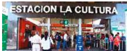
Ampliación de estaciones Las estaciones Villa El Salvador, La Cultura, Gamarra, Miguel Grau y Bayóvar serán modificados para mejorar la accesibilidad de los usuarios.
