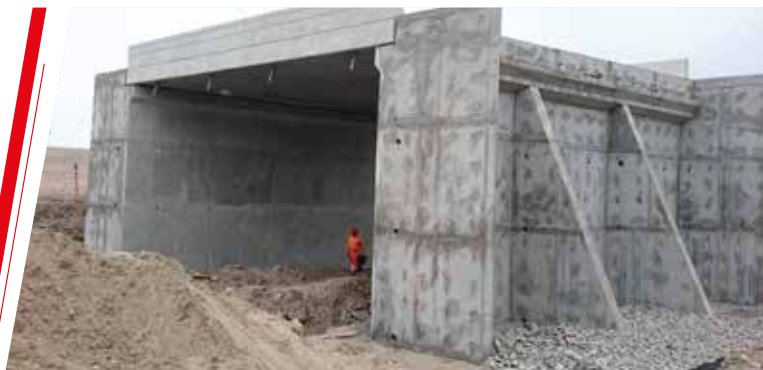
Paso a desnivel San Andrés
