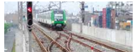
Implementación de 8 cambiavías Facilitarán la maniobra de trenes en la vía y reestablecer el servicio con mayor rapidez en caso de una contingencia.
