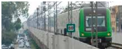
Mejoras en el Sistema Eléctrico El concesionario ampliará la capacidad de los equipos eléctricos.
