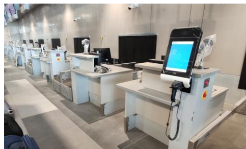
(b) Nuevo Terminal
