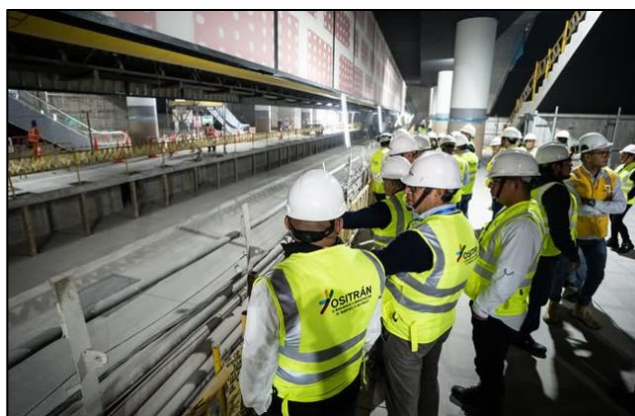
Ilustración N° 7 Visitas de campo a las infraestructuras en el año 2024
