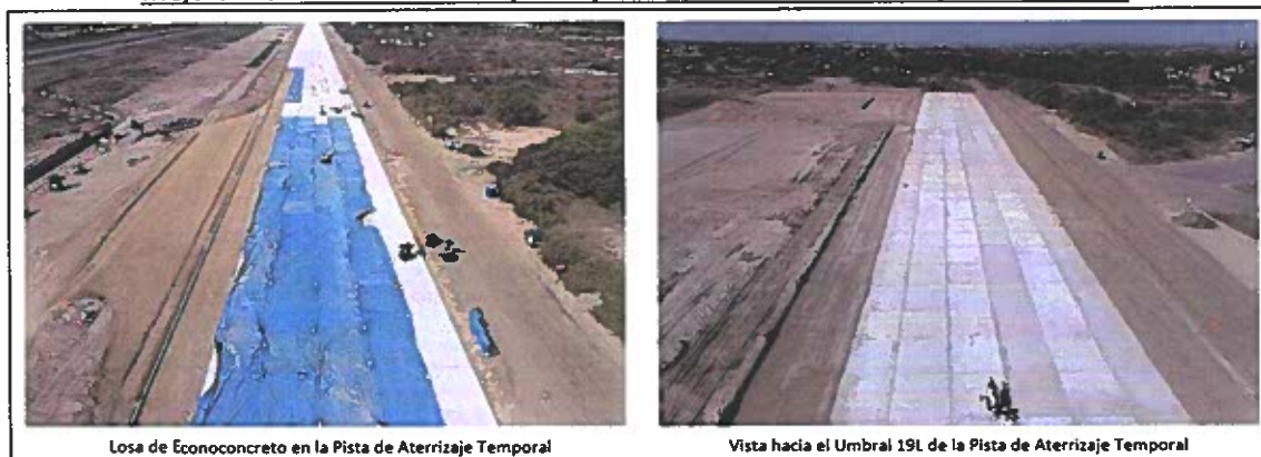
Imagen N° 09 Mejoramiento del sistema de pistas y cerco perimétrico del Aeropuerto de Piura
