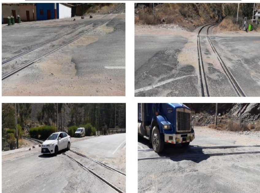
Cruces ferroviarios ubicados en el Tramo 2 de la carretera IIRSA Centro
