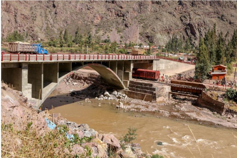
Imagen N° 1 Puente Huarcoondo y Pachar
