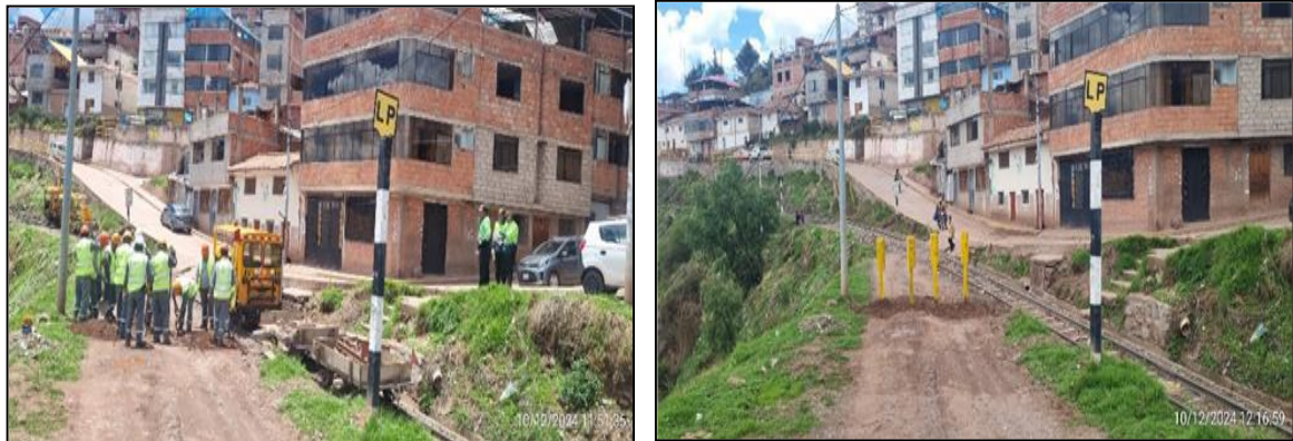
Imagen N° 5 Clausura del paso a nivel ubicado en el Km 6+500
