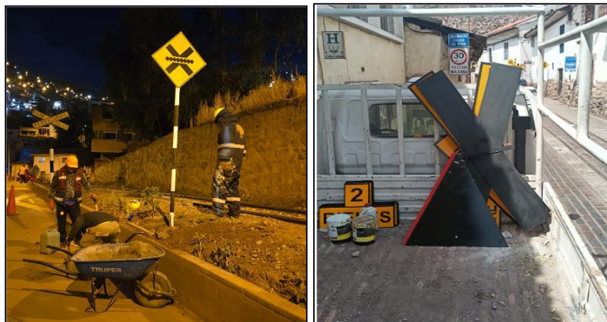
Imagen N° 6 Señalización en los pasos a nivel formales Km 2+551 y Km 3+175
