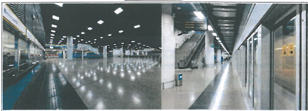
Imagen N° 5 Vestíbulo y Andenes
