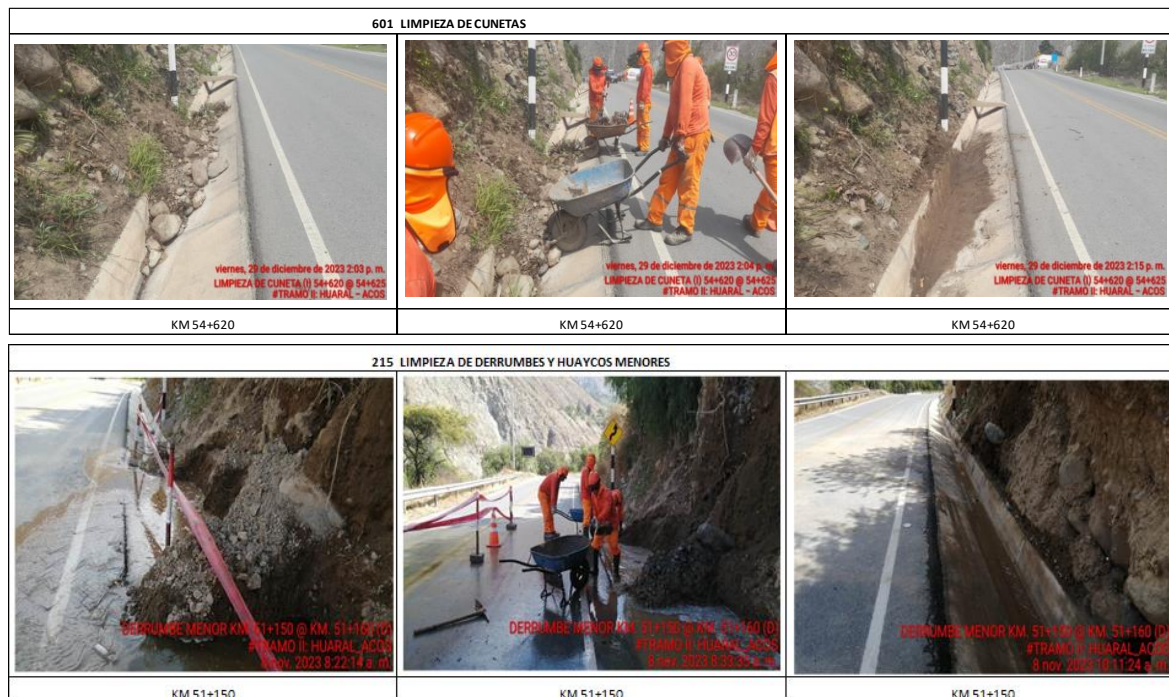
Imagen N° 02 Actividades de mantenimiento
