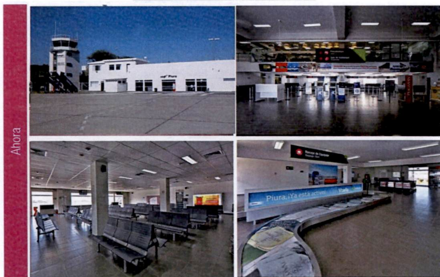
Imagen N° 1 Estado actual del Aeropuerto de Piura
