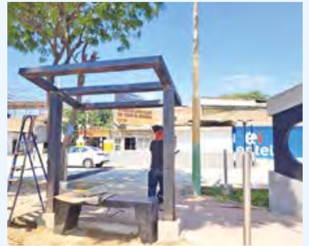
CONTINÚAN LOS TRABAJOS EN LA AVENIDA CORPAC.
