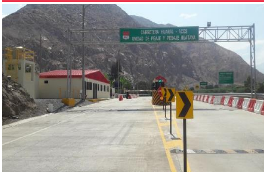
Figura N° 2 Unidad de Peaje y Pesaje Huataya
