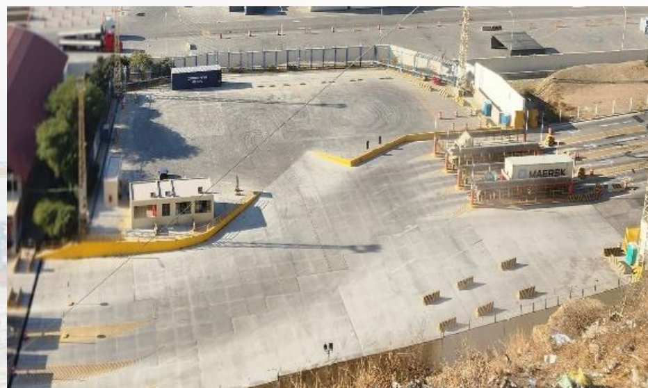
Obra Gate: Modificación de Ingreso de Vehículos Mayores
