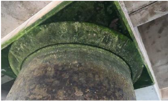
Mantenimiento de pilotes del muelle
