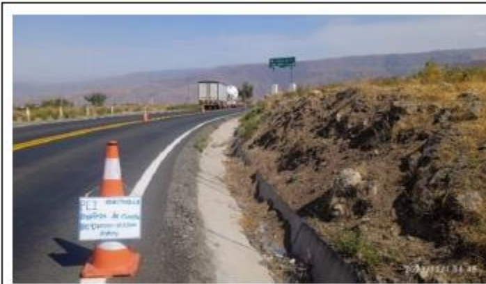
Limpieza de cunetas revestidas manual Antes Sector 3: Nazca – Dv. Pampichiri Progresiva: KM 43+000 – 46+200
