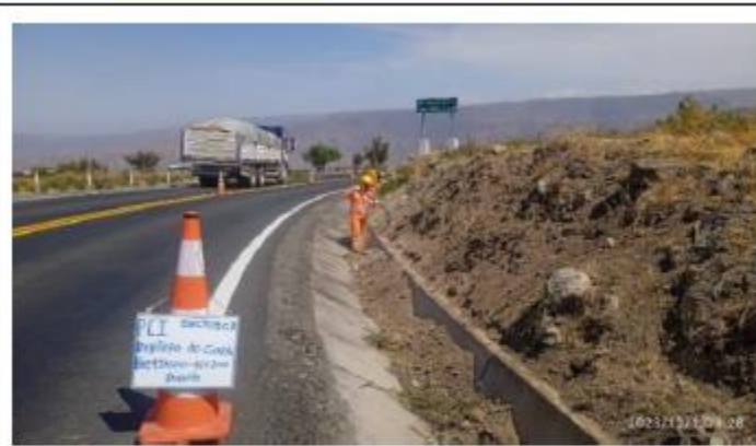
Limpieza de cunetas revestidas manual Durante Sector 3: Nazca – Dv. Pampichiri Progresiva: KM 43+000 – 46+200
