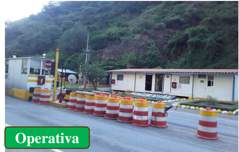
Estación Peaje de Pichirhua Km 411+700
