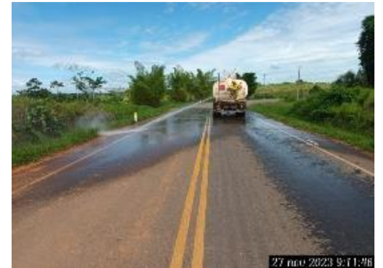
Limpieza de calzada y bermas
