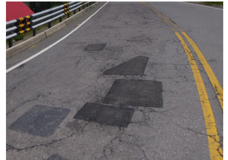
Reparación de Bache
