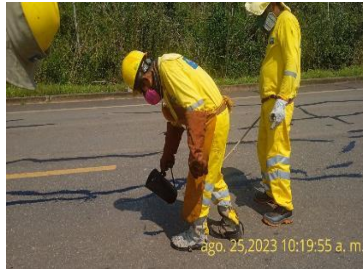
Tratamiento y sellado de fisuras
