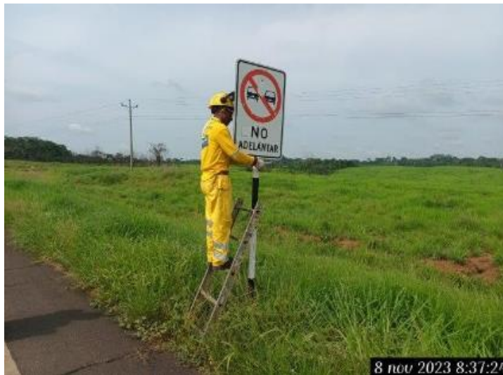
Reposición De Placas De Señalización Vertical
