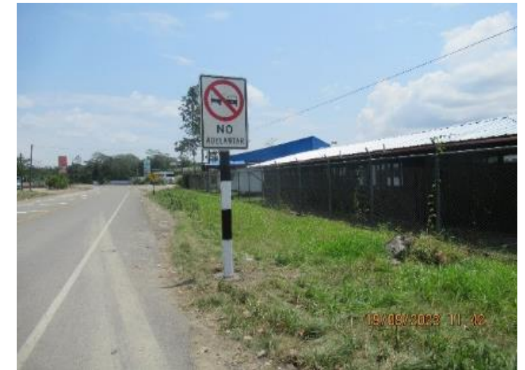
Reposición de postes de señalización vertical
