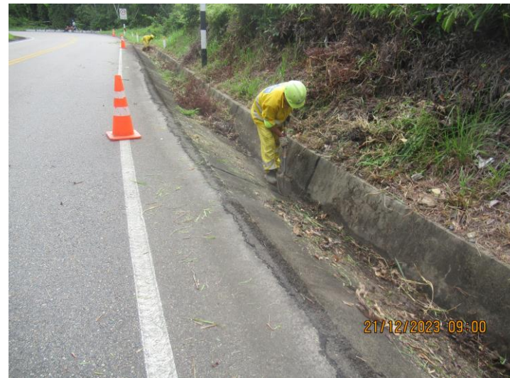
Limpieza de Cuneta
