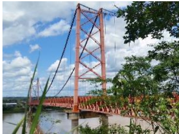
Decoloración de la Pintura del Puente
