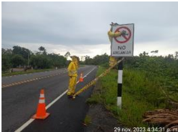
Limpieza de Placas de Señalización
