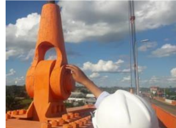
Desprendimiento y Cuarteamiento de la Pintura
