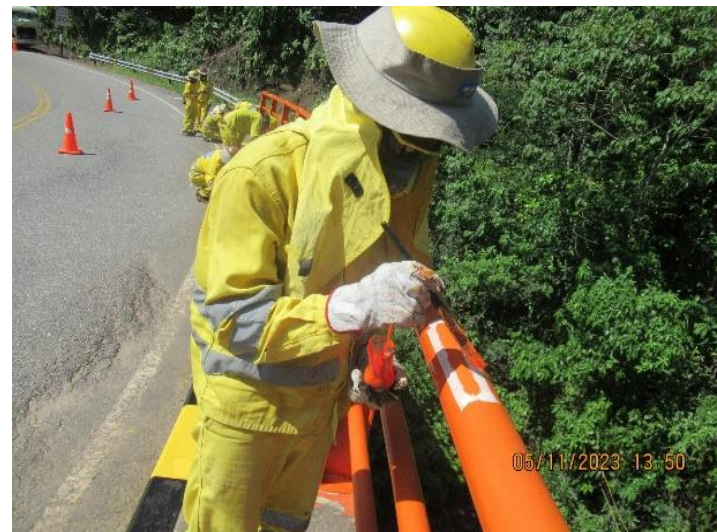
Repintado de barandas metálicas
