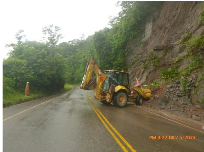
Limpieza de deslizamientos menores
