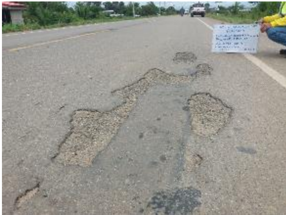
Deterioro del Pavimento
