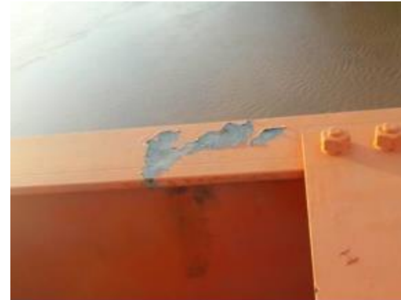
Desprendimiento y Cuarteamiento de la Pintura
