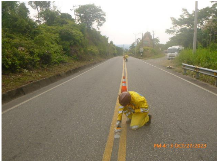
Reposición de tachas reflectivas
