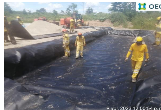
Impermeabilización de los acopios de residuos peligrosos
