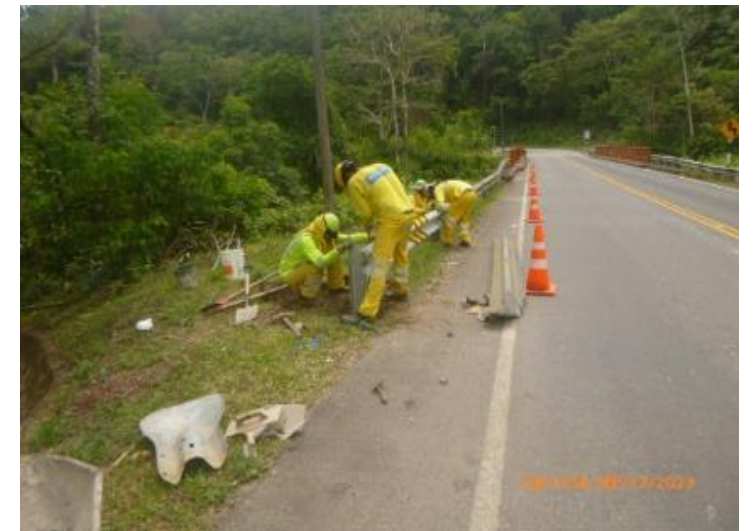
Reposición de guardavías
