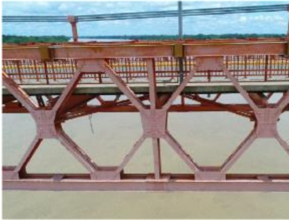
Decoloración de la Pintura del Puente
