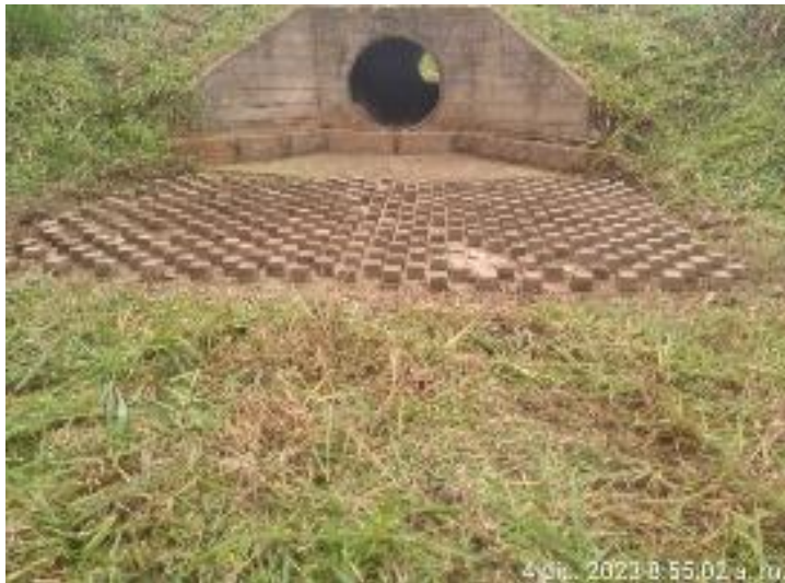
Reposición de cabezal de alcantarilla
