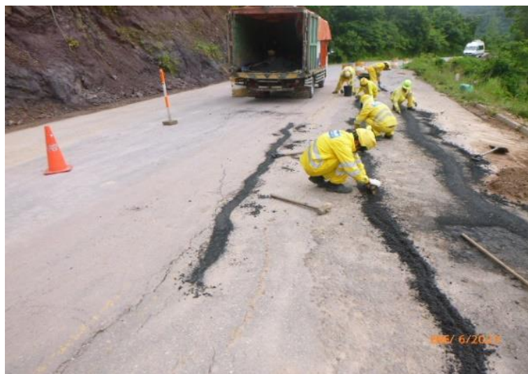
Tratamiento de fisuras
