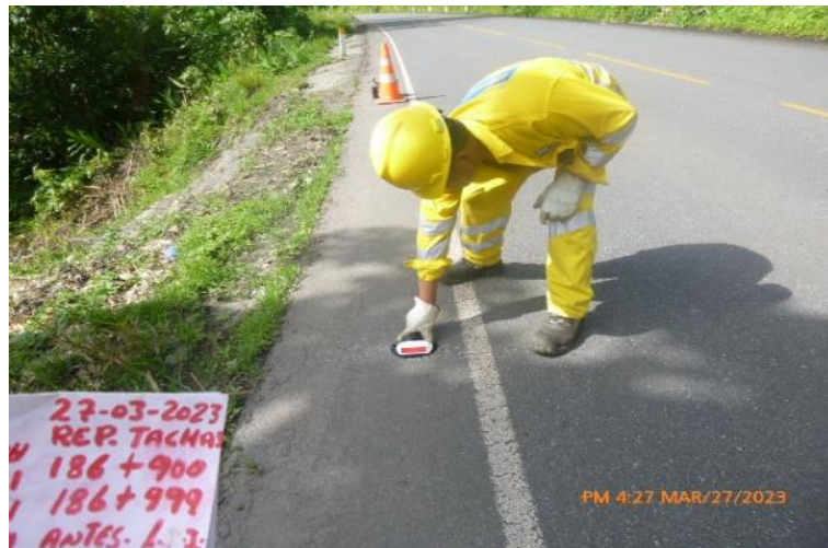
Reposición de tachas reflectivas
