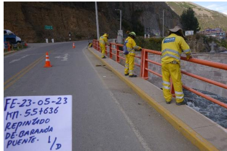
Reparación de superficie de concreto puentes/pontones
