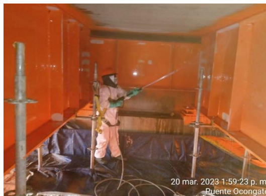
Instalación del sistema de encapsulado
