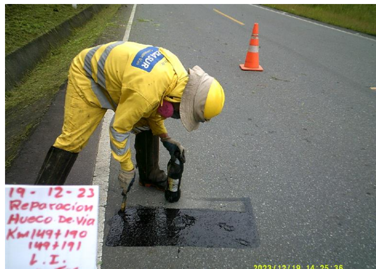
Reparación de bache superficial
