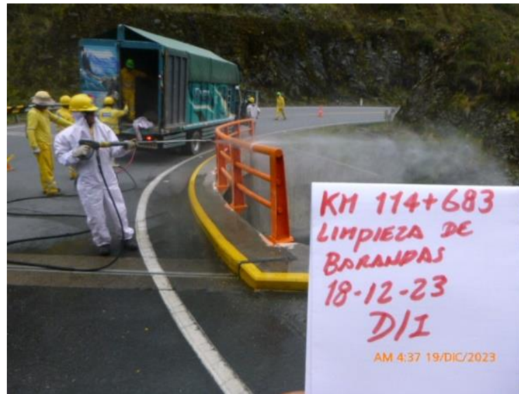
Repintado y limpieza de barandas metálicas
