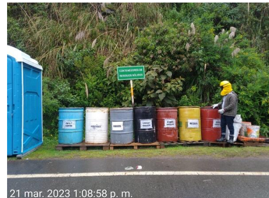
Segregación de residuos sólidos
