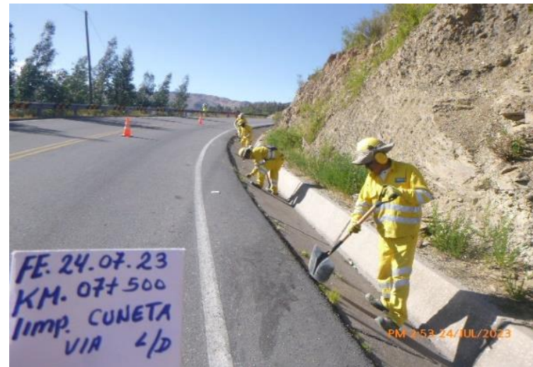
Limpieza de cuneta de vía
