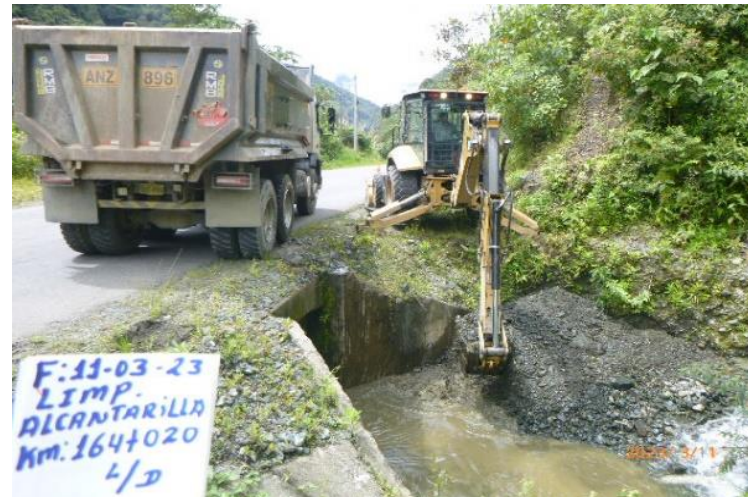
Limpieza de alcantarillas
