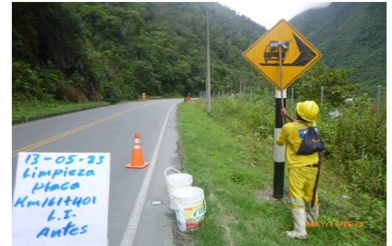
Limpieza de placas de señalización
