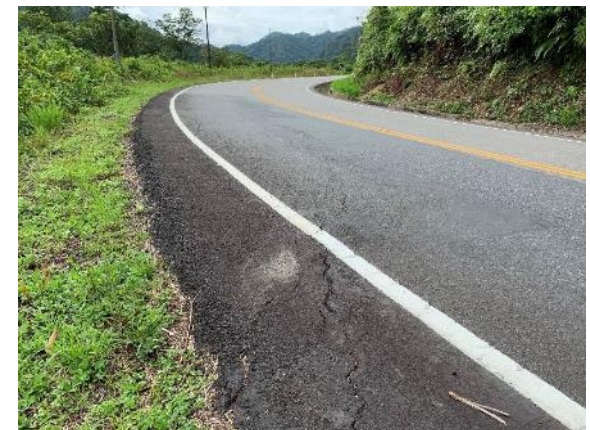
Deterioro del Pavimento
