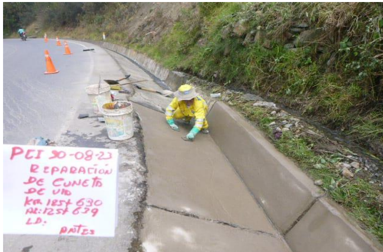
Reparación de cuneta de vía
