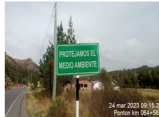
Instalación de señalización Ambiental
