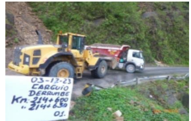
Remoción de derrumbes
