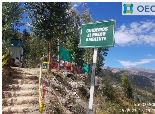
Implementación de señalización Ambiental
