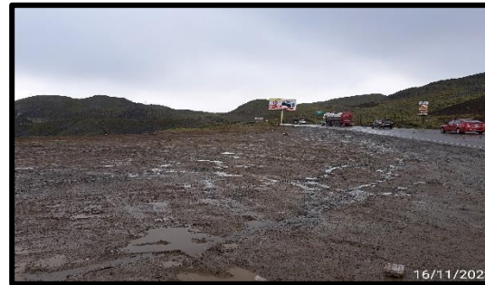
DME – Km. 122+500 SUB TRAMO 3
