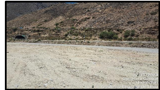
DME – Km. 079+880 SUB TRAMO 1
