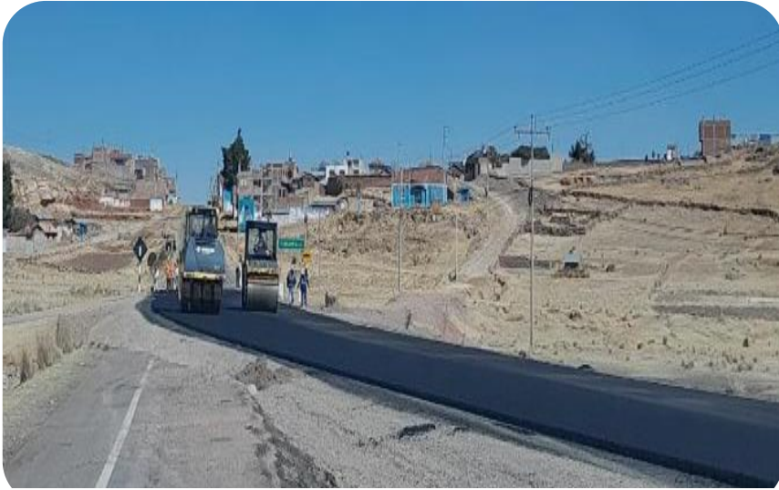
PAUCARCOLLA: Colocación de la carpeta asfáltica Km 24+200
