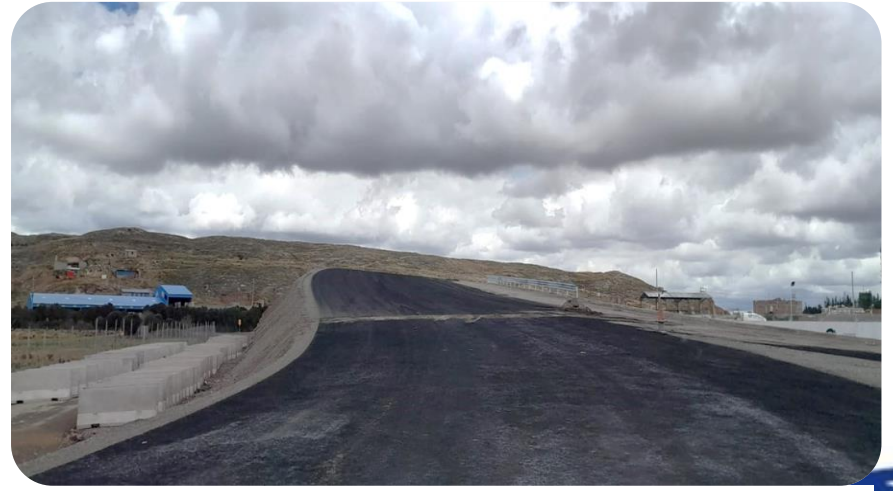
CARACOTO: Colocación del imprimado entre el Km 5+020 al Km 5+350
