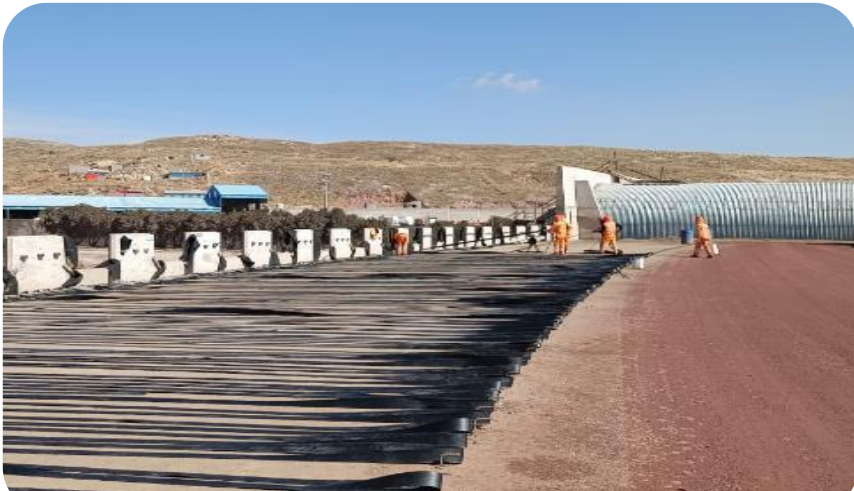
CARACOTO: Ejecución del muro de suelo reforzado, colocación de fajas estructurales Km 5+020 al Km 5+280
