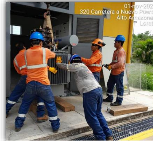
Cambio de Transformador y Transformix
