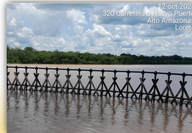
Mantenimiento de defensa contra palizada - cambio de estructuras
