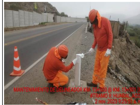
824 CONSERVACIÓN DE OTROS ELEMENTOS DE SEGURIDAD VIAL (POSTES DELINEADOR)
