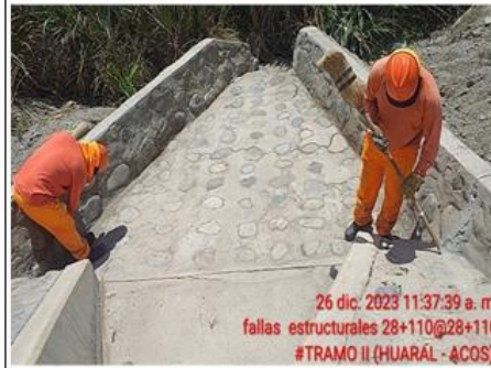
617 REPARACIÓN MENOR DE ALCANTARILLAS DE CONCRETO
