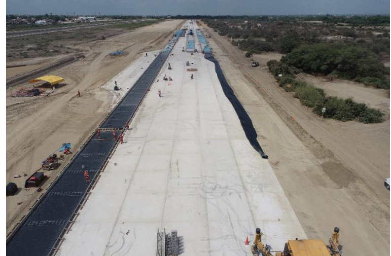
Ejecución de Losas de Concreto en la Pista de Aterrizaje Temporal
