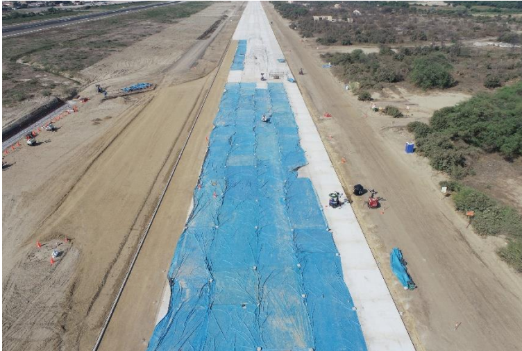
Losa de Econoconcreto en la Pista de Aterrizaje Temporal
