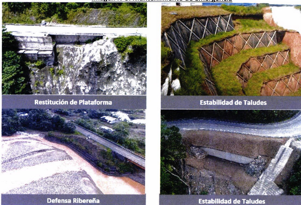
Imagen N°3: Mantenimiento de emergencia
