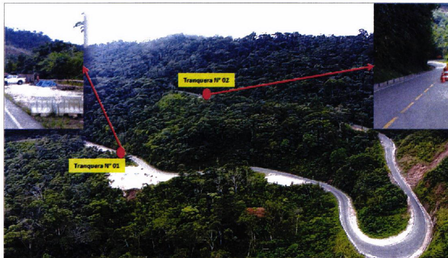
Imagen N° 8: Situación actual del km 17
