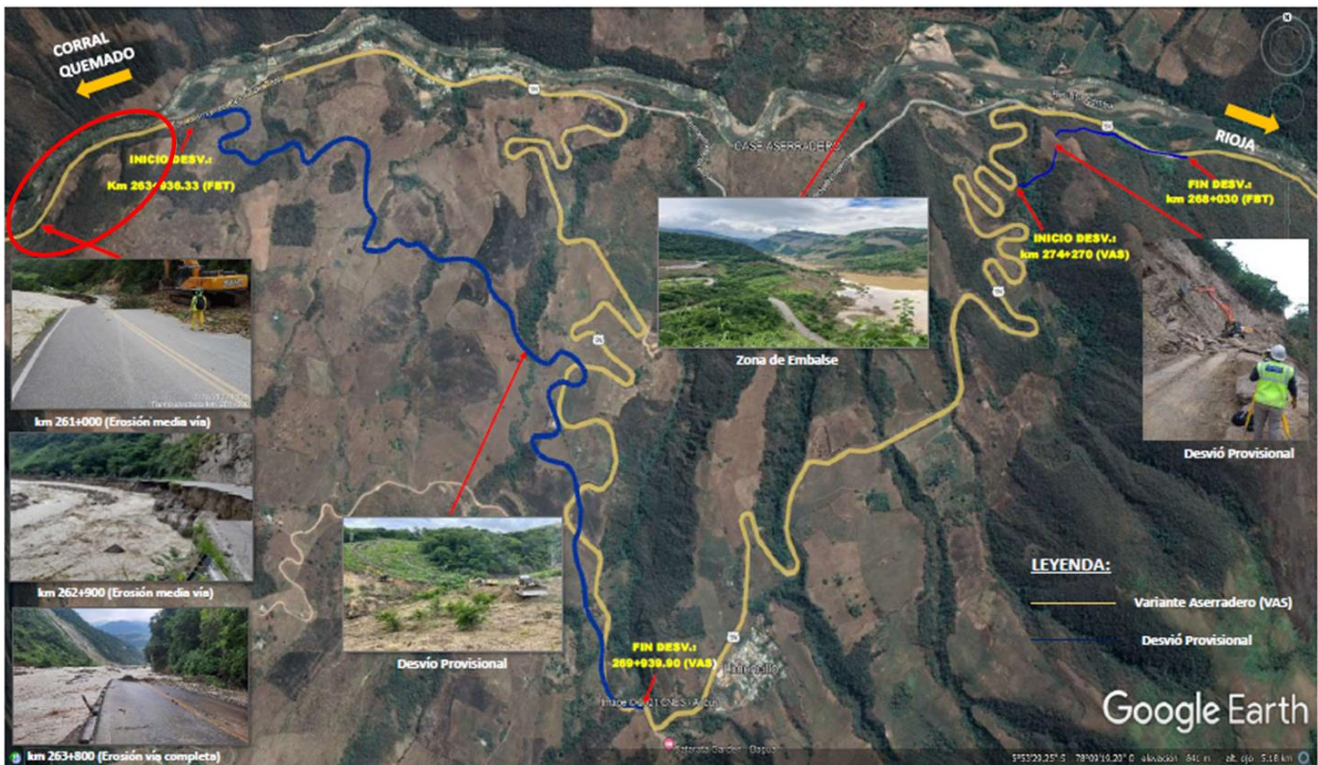
Imagen N° 2 Vista panorámica de los dos desvíos efectuados por el concesionario
