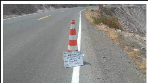
Reconformación de bermas - Antes Sector 3: Dv. Nazca - Dv. Pampachiri Progresiva: KM 039+000 - 039+500
