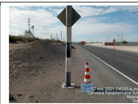
Pintado de postes - Antes Sector 2: Emp. Panamericana - Nazca Progresiva: KM 465+300 - 465+300
