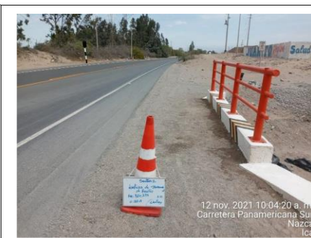
Limpieza de baranda de puente - Después Sector 2: Emp. Panamericana - Nazca Progresiva: KM 465+375 - 465+375
