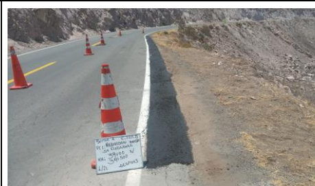
Reconformación de bermas - Después Sector 3: Dv. Nazca - Dv. Pampachiri Progresiva: KM 039+000 - 039+500
