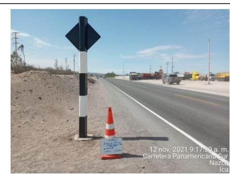
Pintado de postes - Después Sector 2: Emp. Panamericana - Nazca Progresiva: KM 465+300 - 465+300
