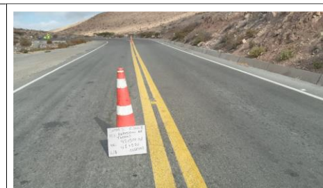
Reposición de tachas - Después Sector 3: Dv. Nazca - Dv. Pampachiri Progresiva: KM 040+500 - 041+000
