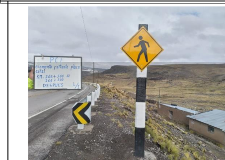
Elementos faltantes - Después Sector 4: Dv. Pampachiri - Chalhuanca Progresiva: KM 366+500 - 266+500
