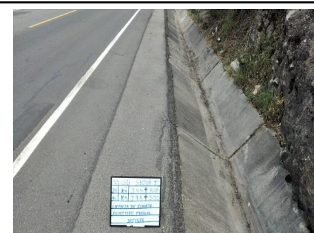
Limpieza de cunetas - Después Sector 5: Dv. Pampachiri - Emp. PE-R3S Progresiva: KM 344+400 - 344+500
