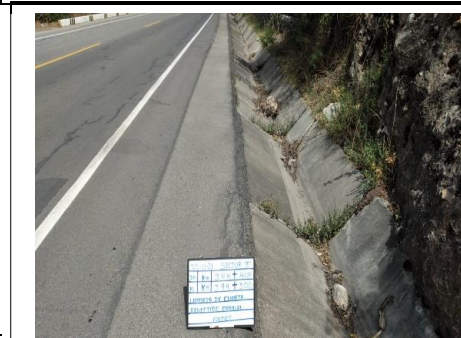
Limpieza de cunetas - Antes Sector 5: Dv. Pampachiri - Emp. PE-R3S Progresiva: KM 344+400 - 344+500
