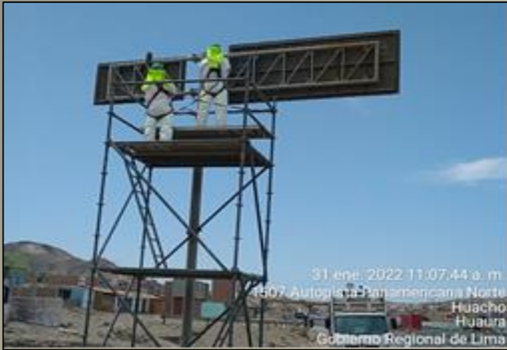
Trabajos de reparación de señales Tramo: Chancay - Huacho
