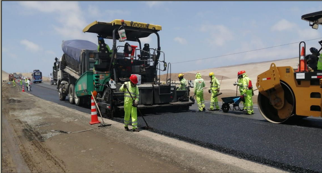
Colocación de MAC
