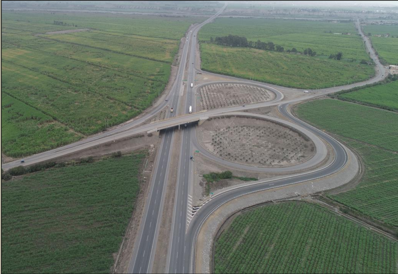
Intersección del Intercambio Vial Pativilca Km 201+800
