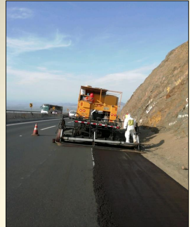
Colocación de material reciclado en bermas
