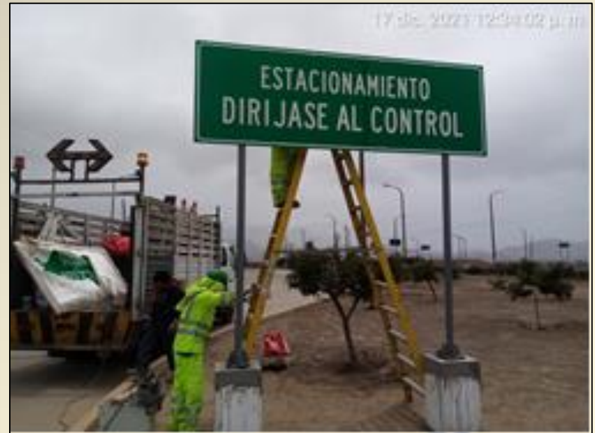
Trabajos de renovación de señalización Tramo: Pesaje
