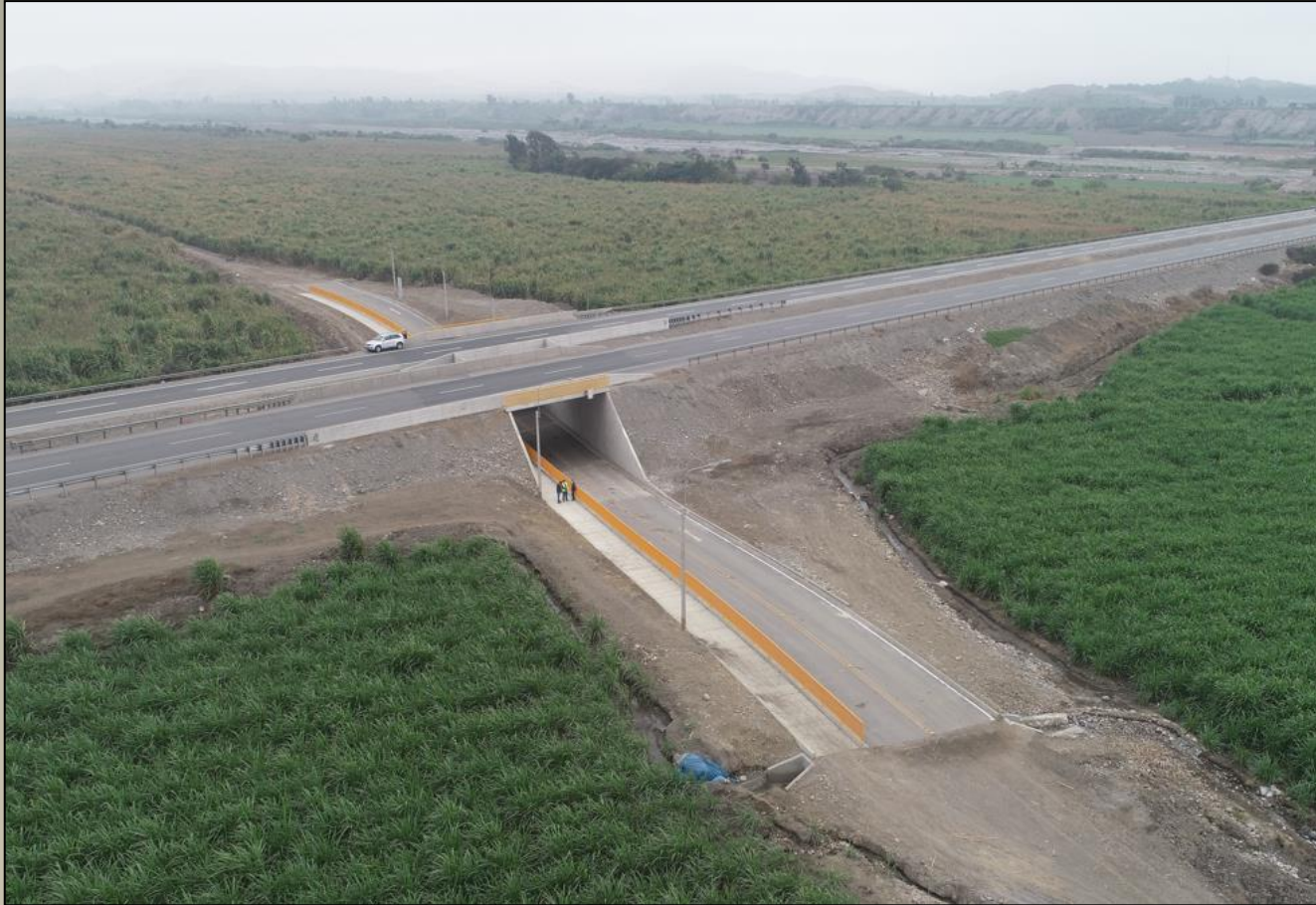
Paso a Desnivel Inferior Peatonal y de Vehículos Menores Km 200+000
