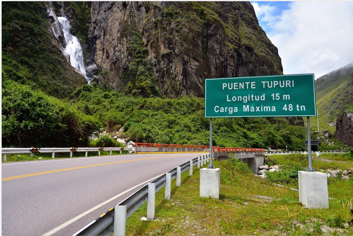
Puente Túpuri Km. 249
