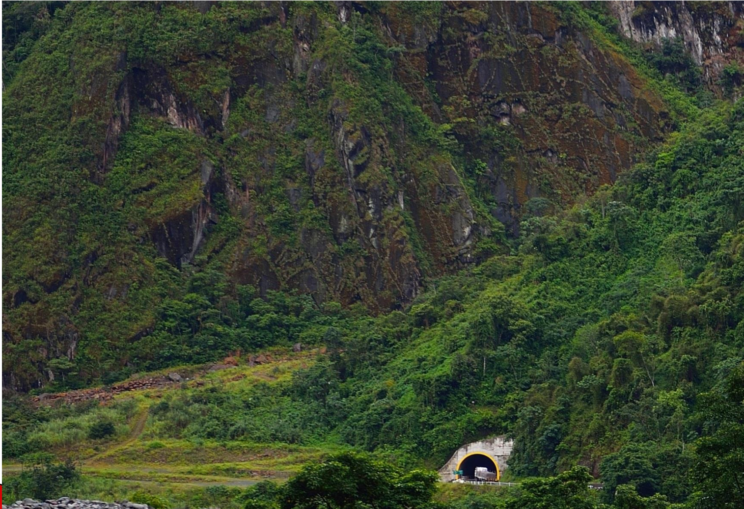
Túnel El Carmen
