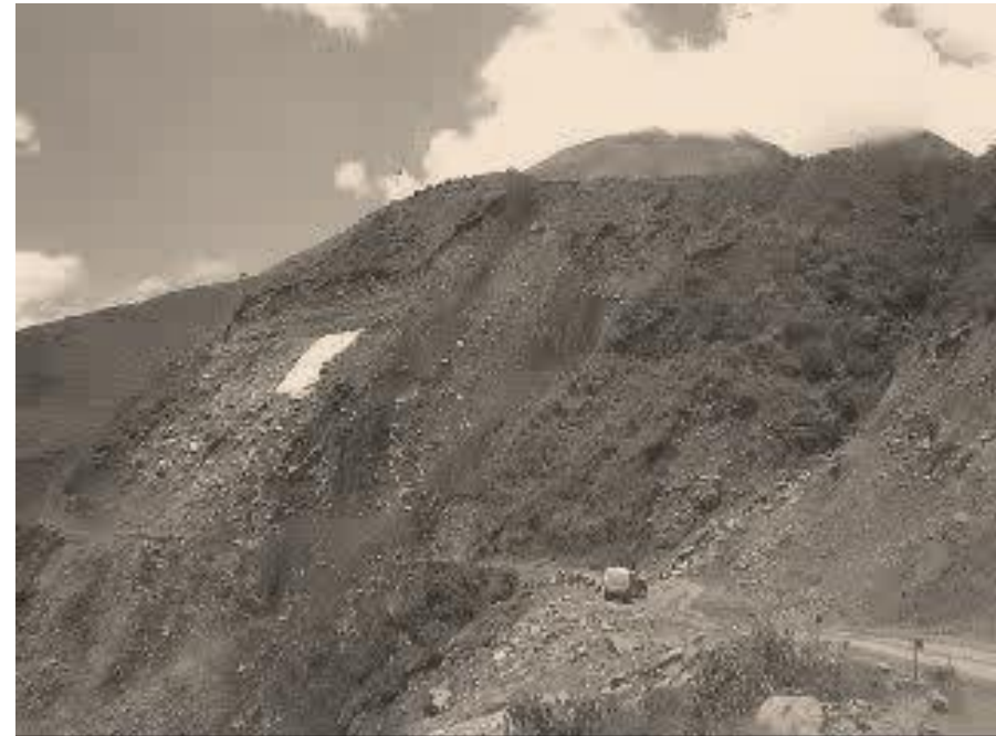
Túnel Wayrasencca (antes)
