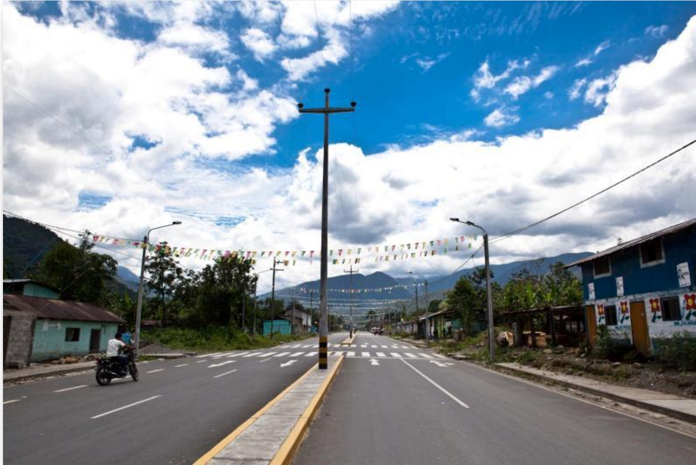
Doble Vía San Gaban Km. 292
