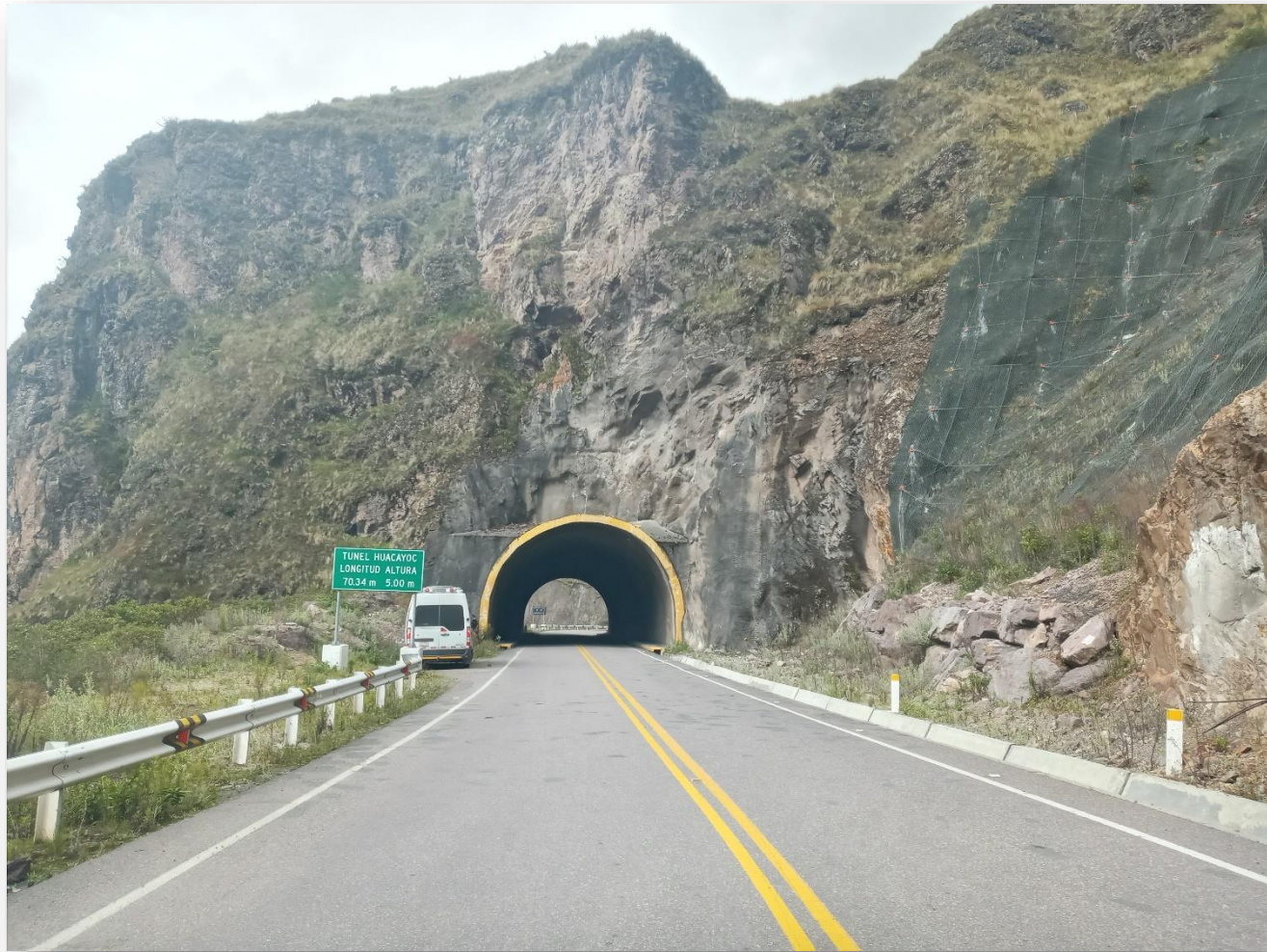
Túnel Huacayoc Km. 213
