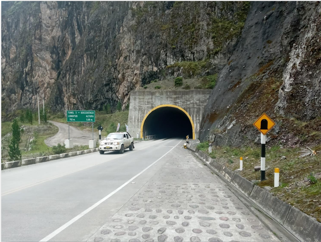
Túnel Soccostaca Km. 222
