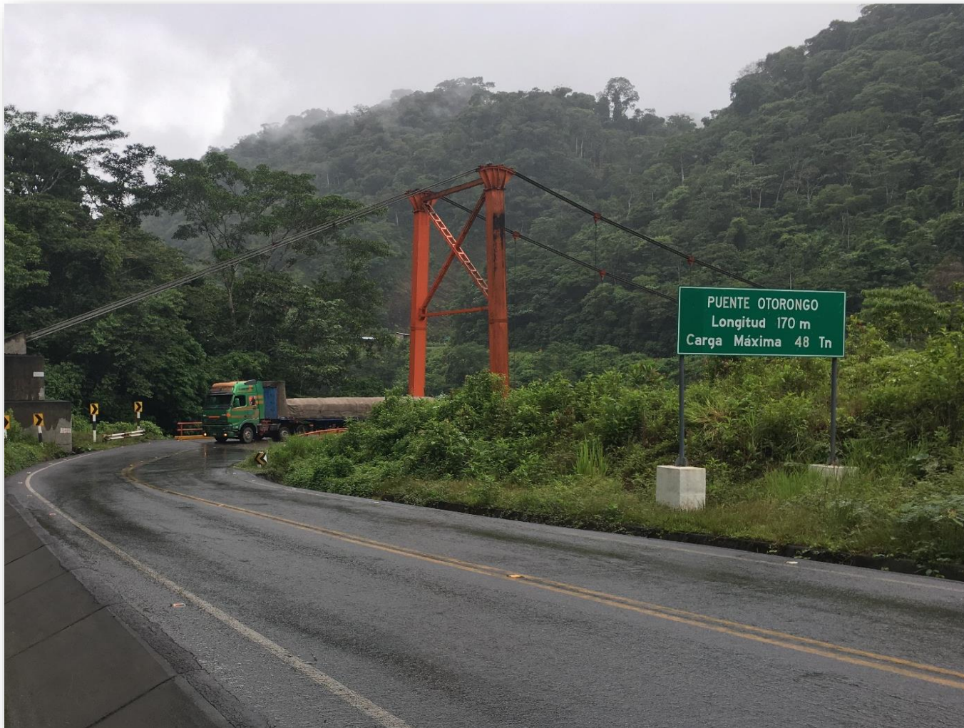
Puente Otorongo Km. 354
