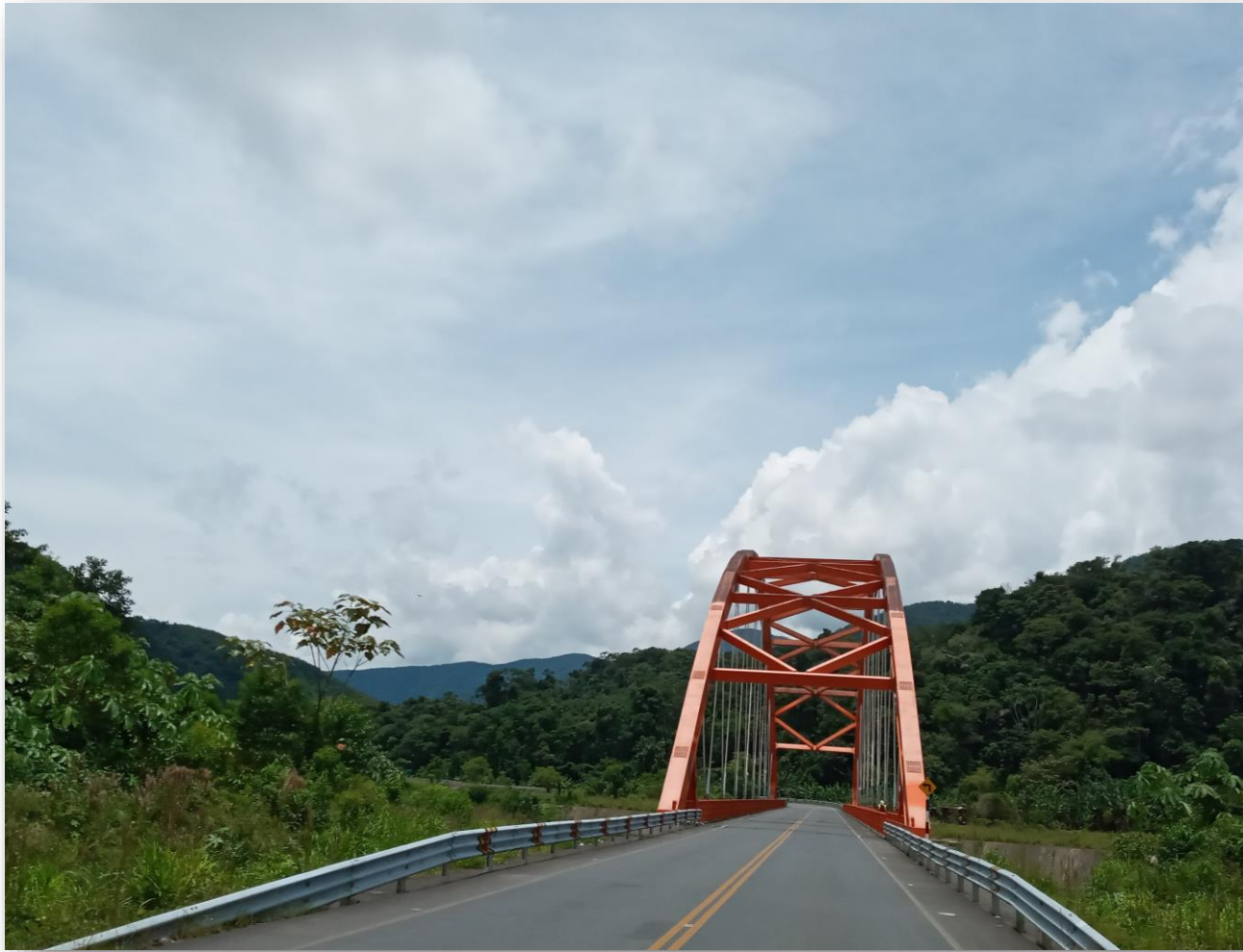
Puente Llocllamayo Km. 295
