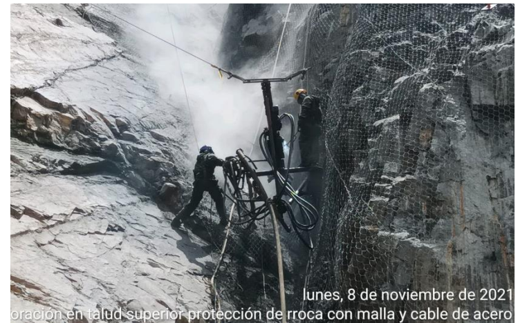
Estabilización de talud - pernos auto perforantes y malla km 278+850 al km 278+950.
