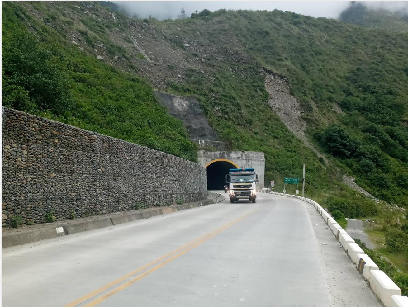
Túnel Wayrasencca Km. 237
