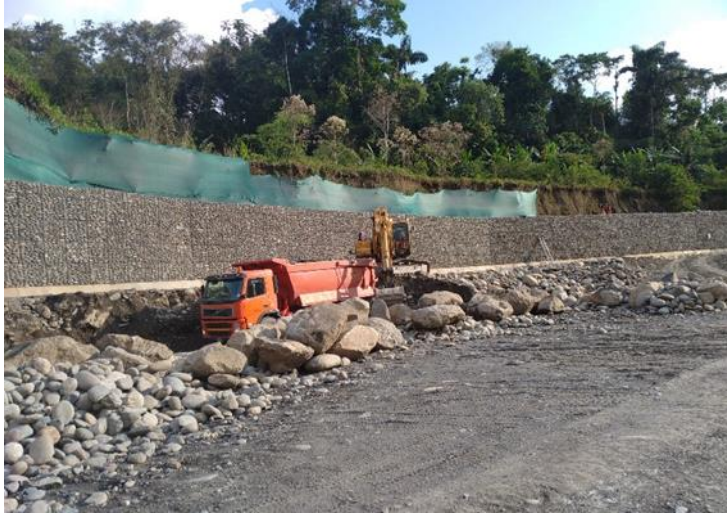
Defensa ribereña Puente Llocllamayo Km 295+186 al km 295+306
