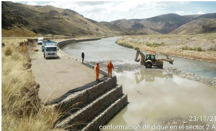
Defensa ribereña San Antón entre el km 103+000 al km 128+000
