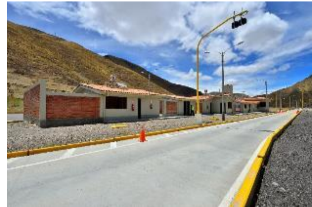
ESTACION DE PESAJE CCATUYO KM 125+500
