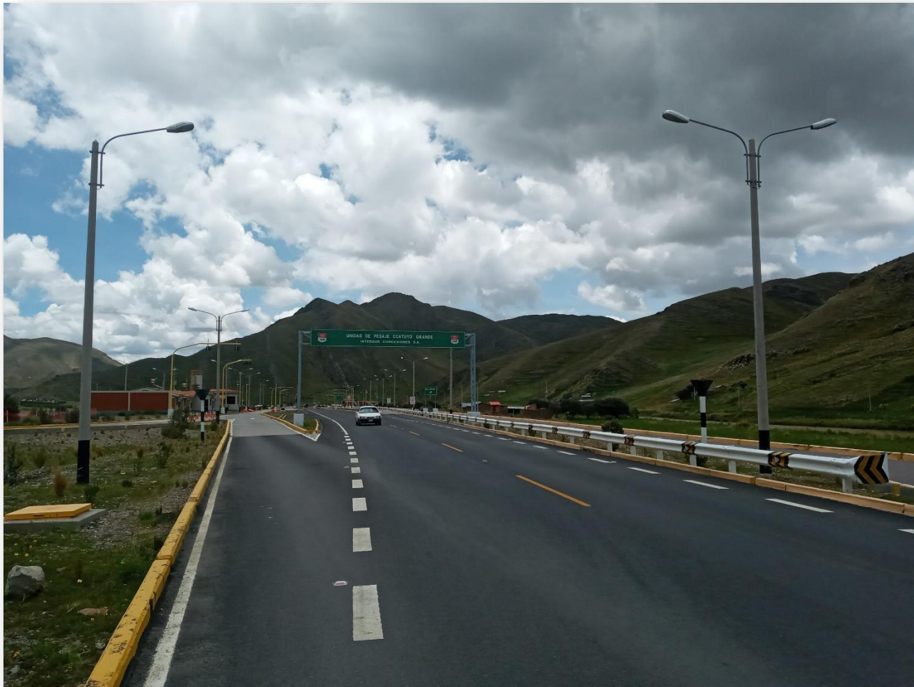
Unidad de Pesaje Ccatuyo Km. 125
