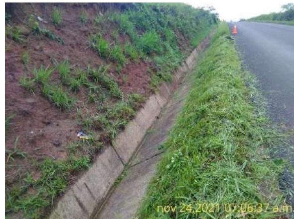
Limpieza de Cuneta
