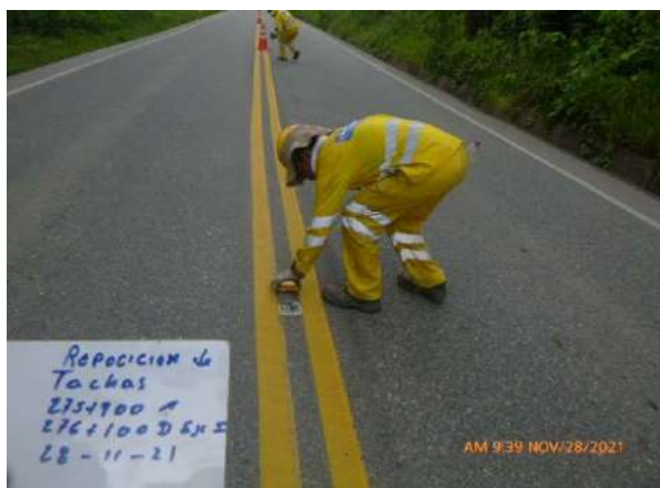
Reposición de tachas reflectivas
