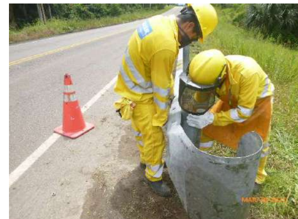
Resane de veredas en puentes/pontones
