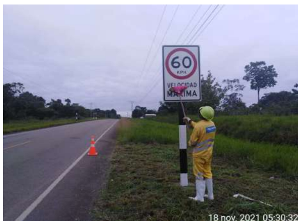
Limpieza de Placas de Señalización
