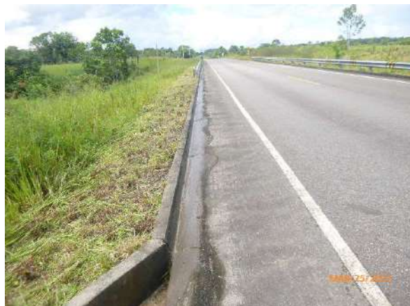
Limpieza de bordillos
