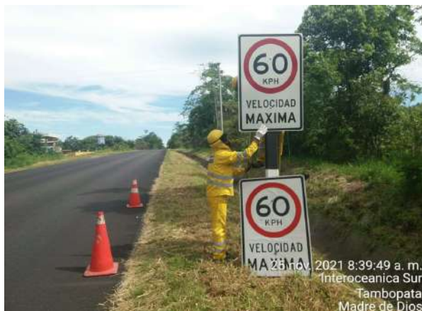
Limpeza de calzada y berma
