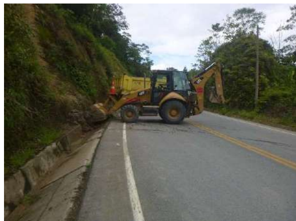
Limpieza de deslizamientos menores
