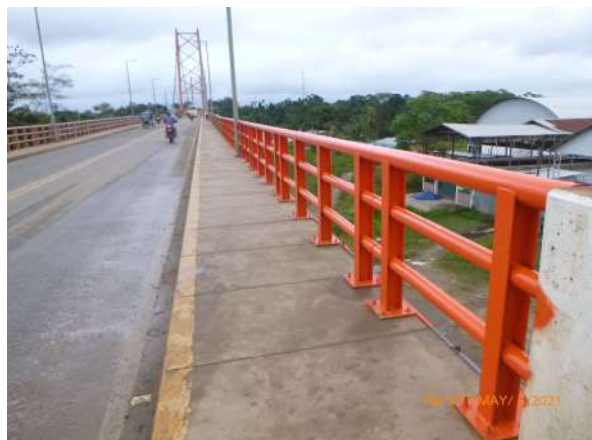
Repintado de barandas metálicas
