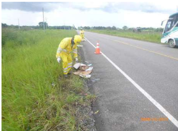
Limpieza de residuos (basura) en el DDV
