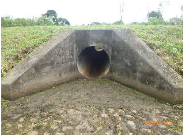
Reposición de cabezal de alcantarilla
