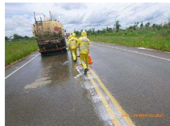
Limpieza de calzada y bermas
