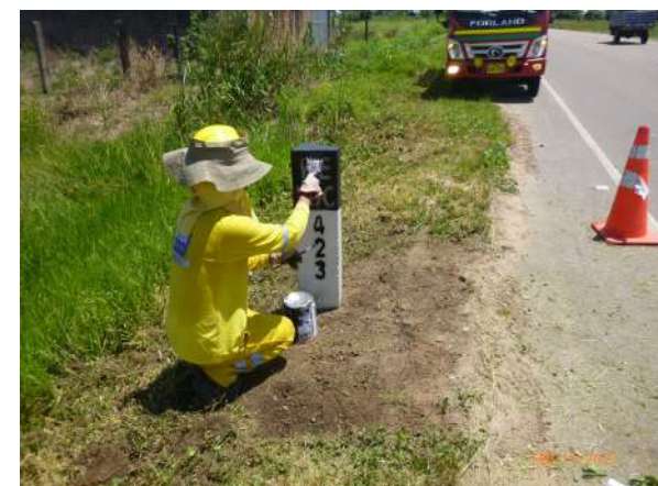
Repintado de postes (hitos) kilométricos
