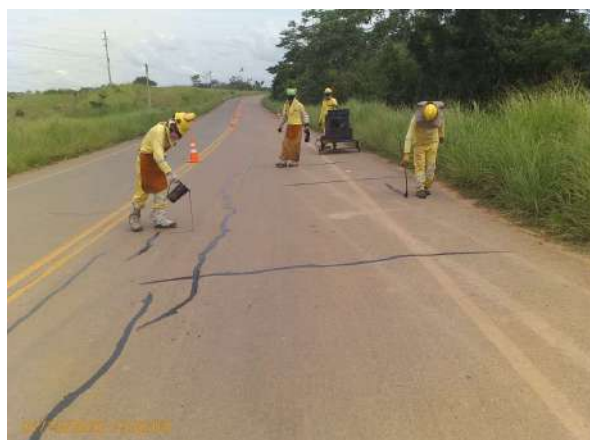
Tratamiento y sellado de fisuras
