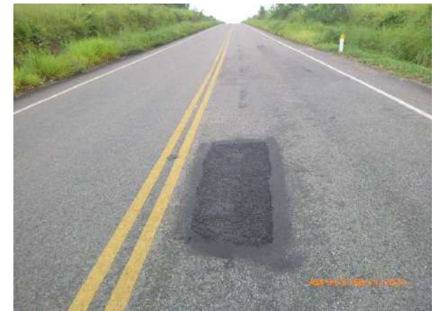
Reparación de Bache
