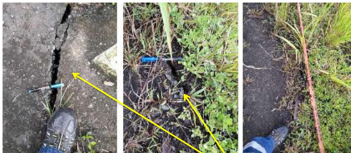
Aparición de fisuras en la berma y talud inferior.
