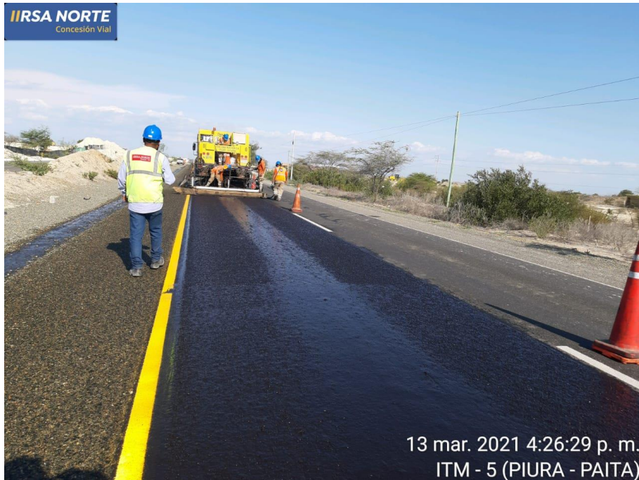
Colocación de Micropavimento e=2.5 cm
