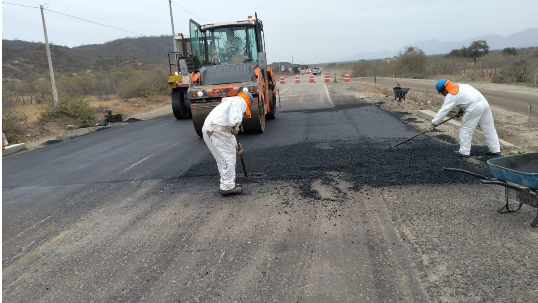
Imprimación y colocación de MAC
