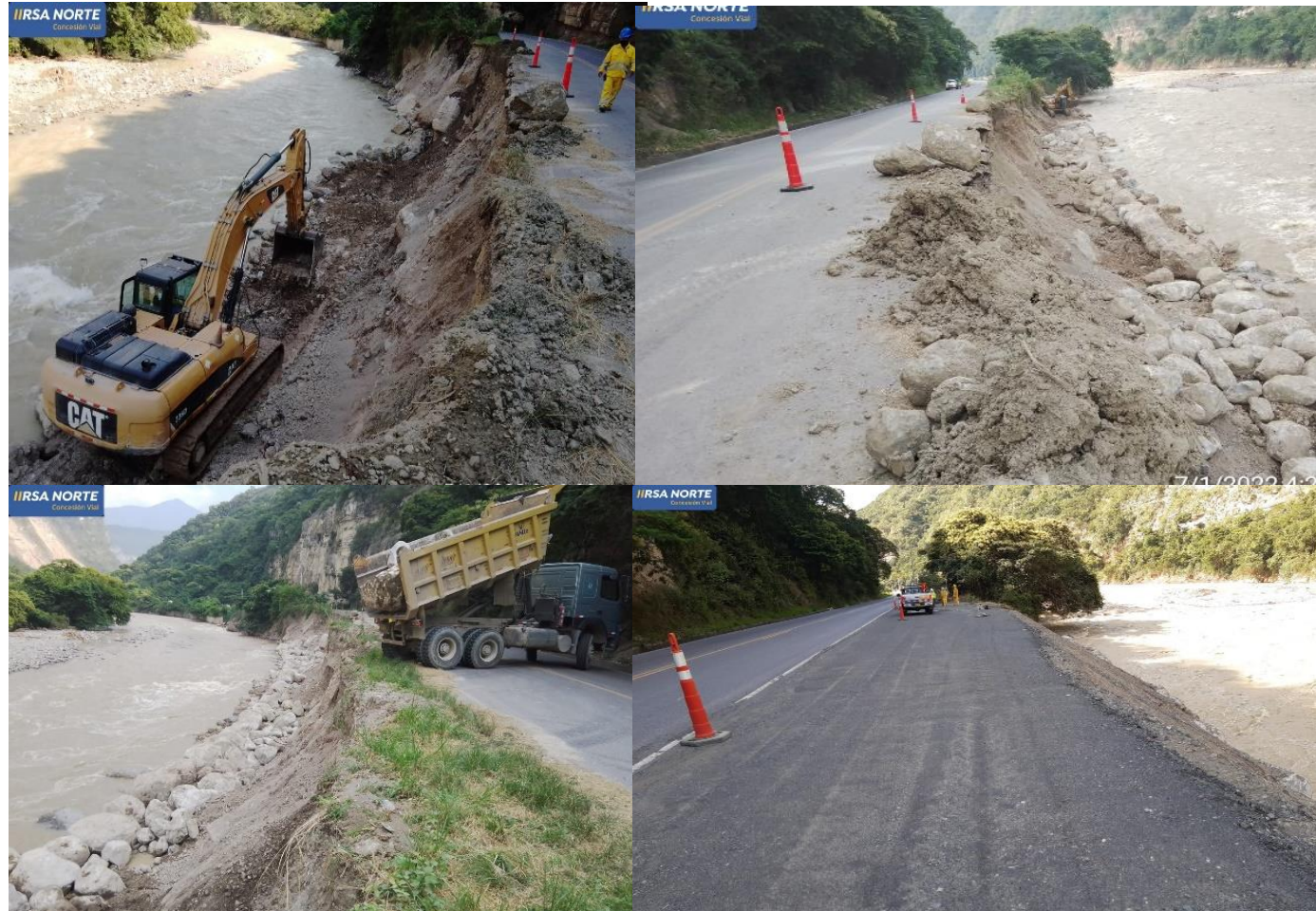
Recuperación de plataforma de la vía
