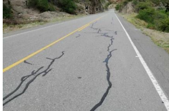
Tratamiento de fisuras
