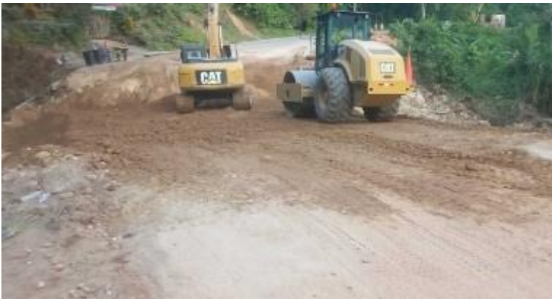
Recuperación de plataforma y transitabilidad de la vía
