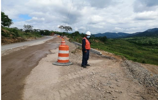
Monitoreo arqueológico para la obra accesoria Km 502+400 al Km 502+460 – Tramo 02.
