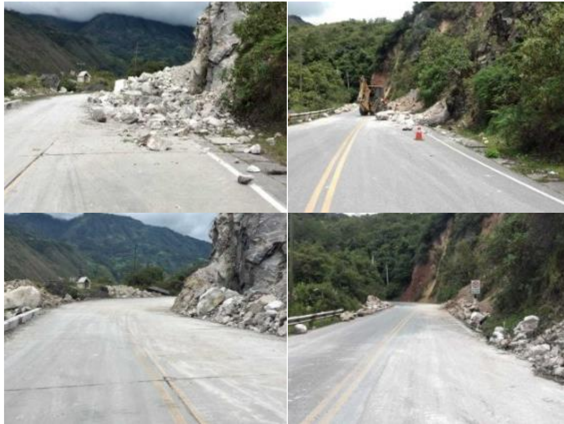
Limpieza de Material rocas sueltas
