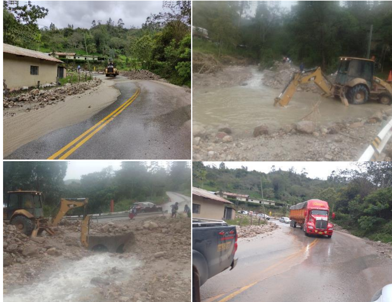
Limpieza de Material Suelto
