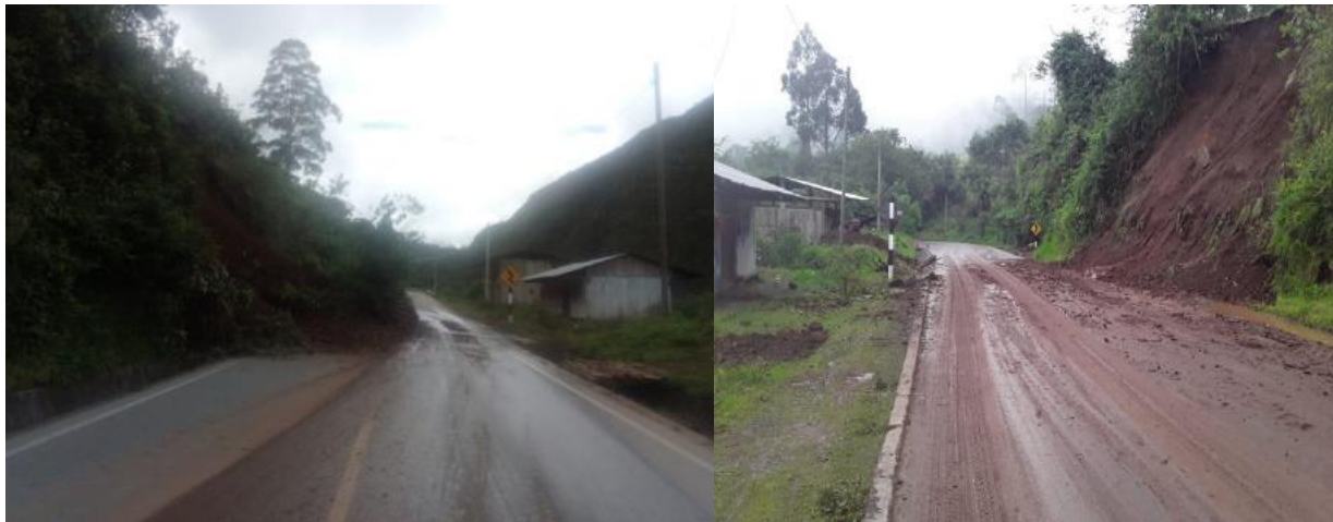
Limpieza de Material Suelto
