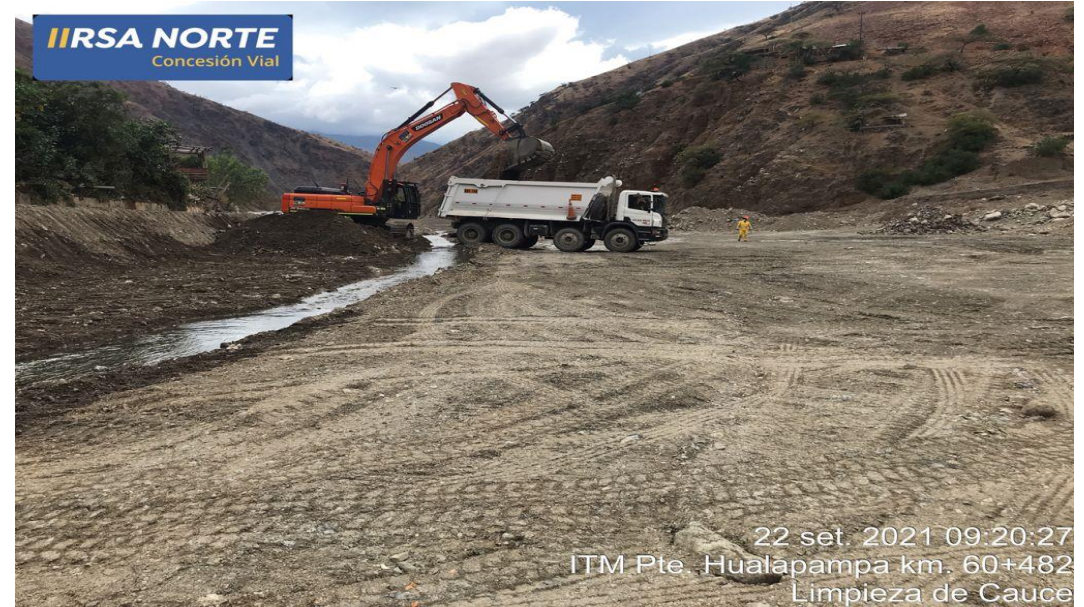
Limpieza de Cauce y protección de muro en la margen derecho
