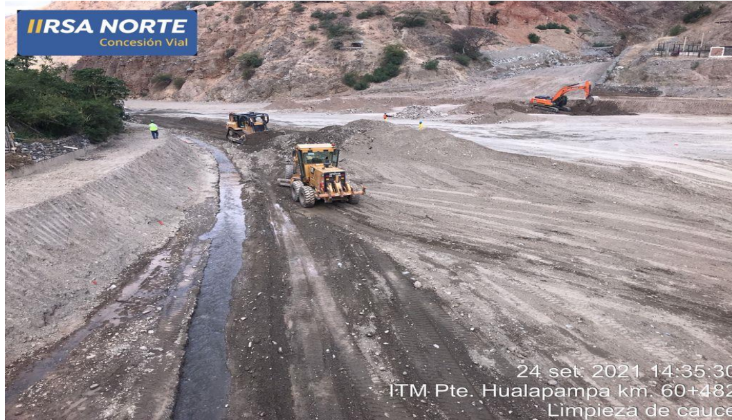
Limpieza de Cauce y protección de muro en la margen derecho
