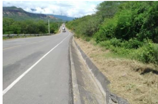
Desbroce de maleza
