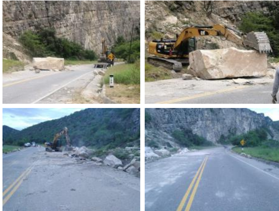
Limpieza y fragmentación de bloque de roca
