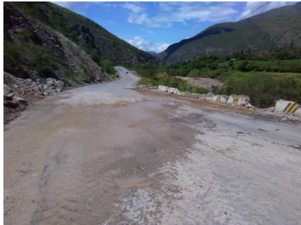
Limpieza de Activación de quebrada
