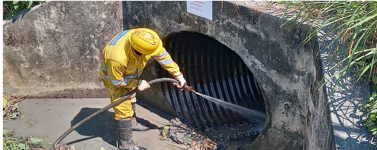
Limpieza de TMC previo a la aplicación de la pintura bituminosa.
