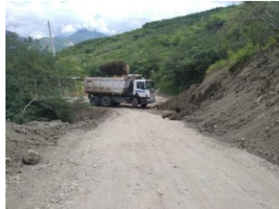
Limpieza de Deslizamiento
