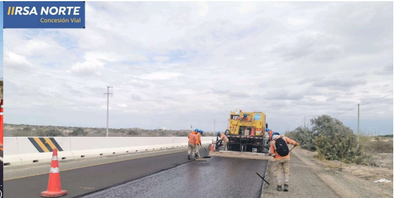
Colocación de Micropavimento e=2.5 cm
