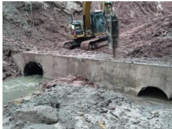
Descolmatación de Alcantarilla
