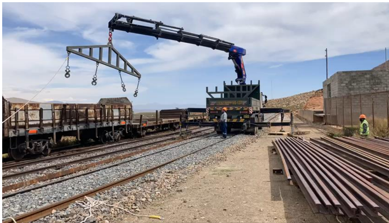
Proceso de carguío de rieles con camión grúa.
