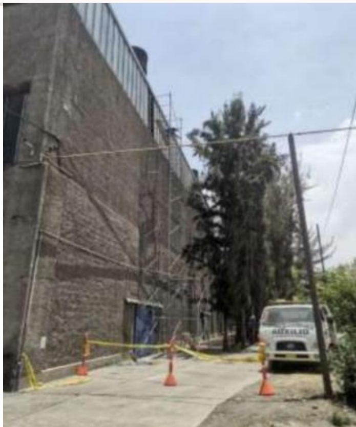
ESTACION AREQUIPA: Retiro y cambio de cristales de taller de montaje
