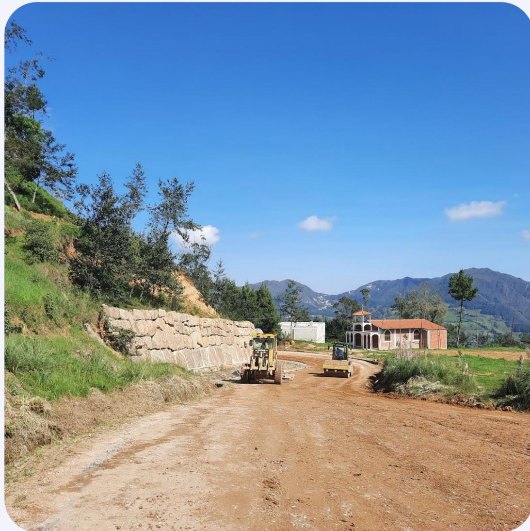
**Fotografía 1: Perfilado de superficie
