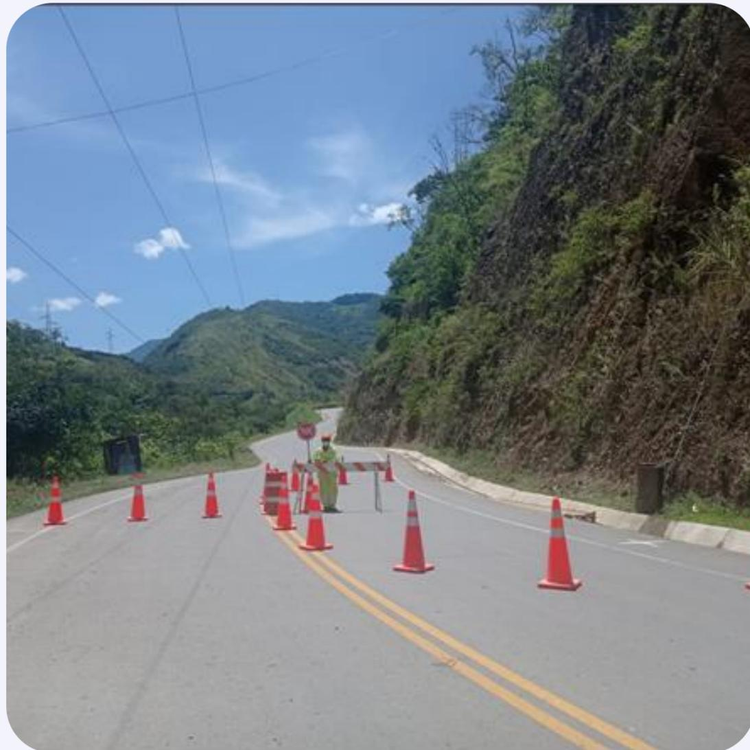
**Fotografía 37: Señalización en actividades de limpieza de derrumbes**
