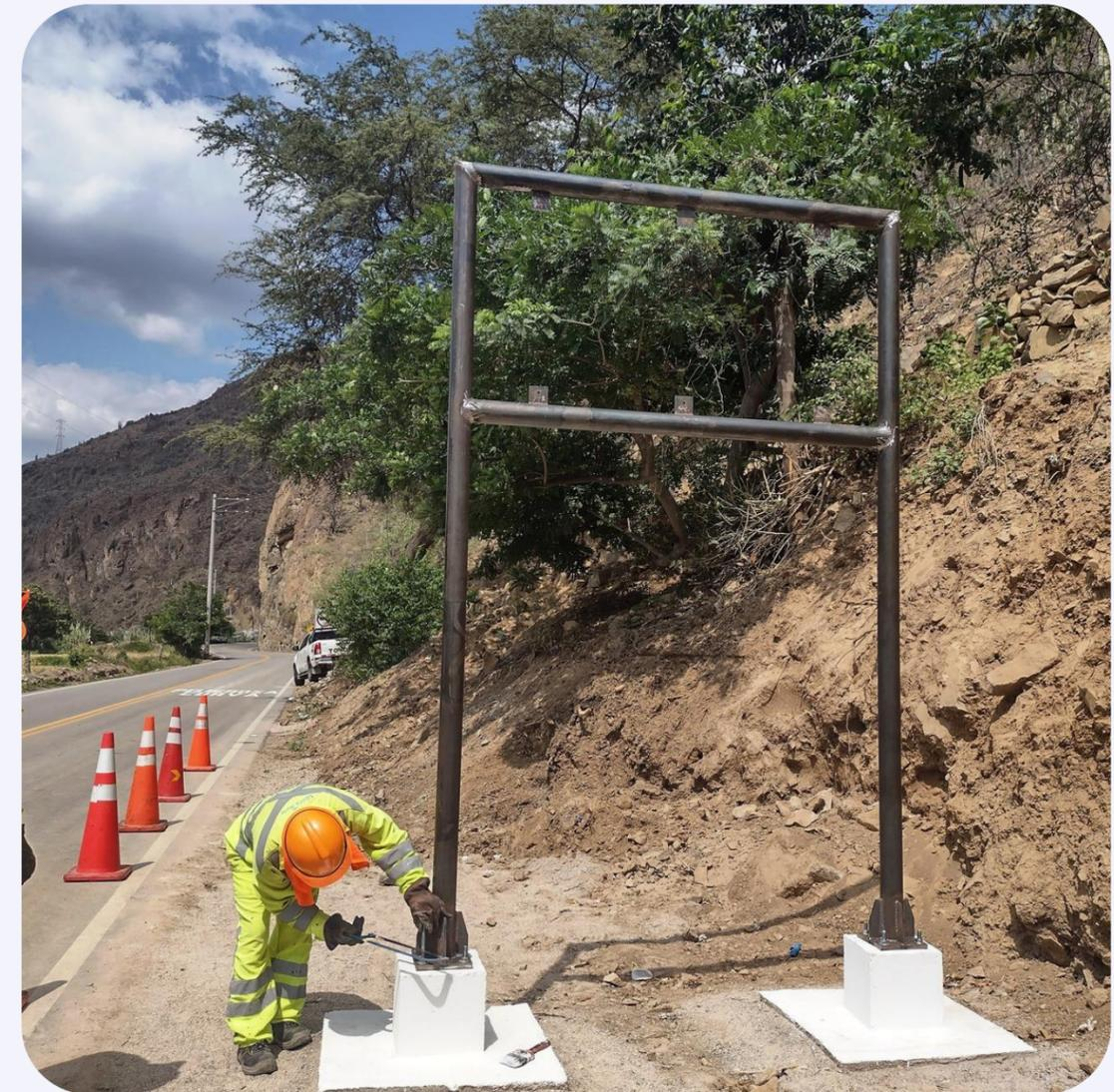
**Fotografía 18: Instalación de pórtico para señal informativa
