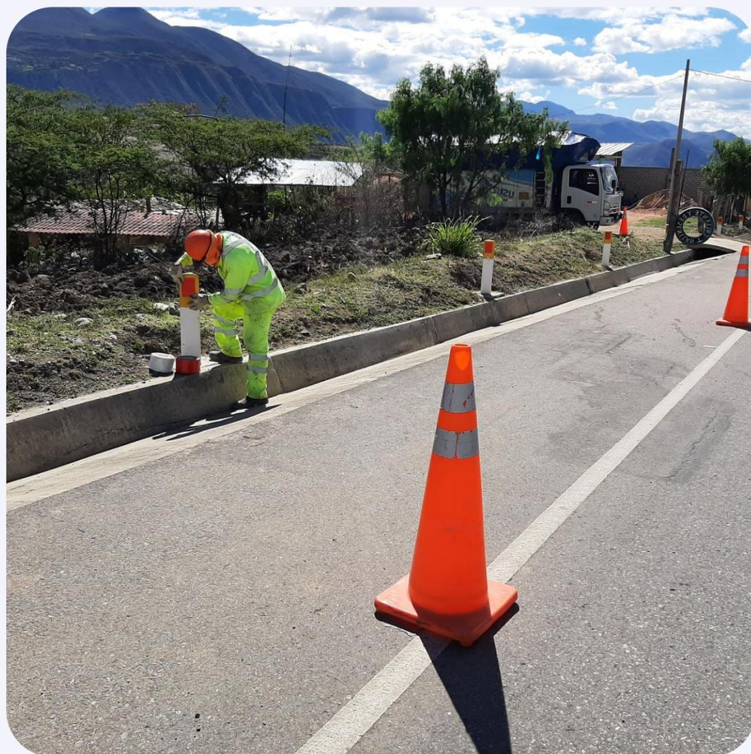
**Fotografía 27: Reposición de láminas reflectivas
