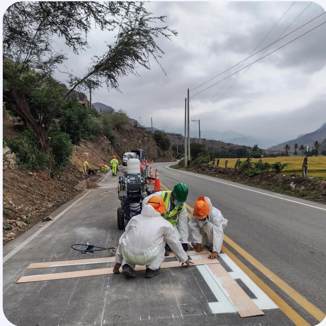
**Fotografía 17: Pintado de marcas en el pavimento con equipos
