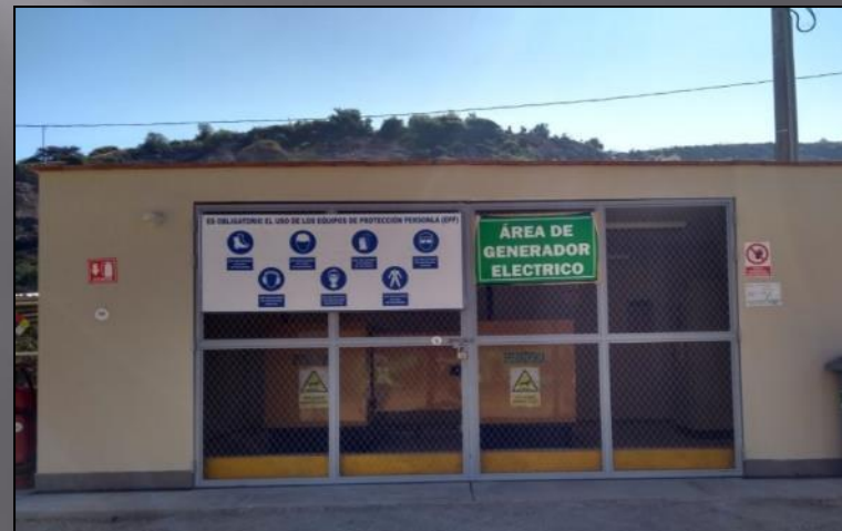
Para la seguridad de los trabajadores, es obligatorio el uso de elementos de protección para ingresar al cuarto de máquinas
