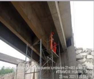
y lavado de elementos extraño puente lumbrá (I) 21+483 al km 21+503 #TRAMO II: HUARAL - ACOS #TRAMO II: HUARAL - ACOS
