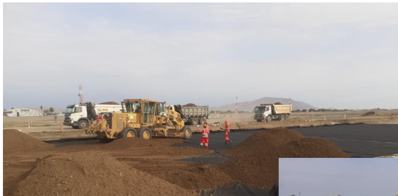
Trabajos en subcapas en la TWY B1
