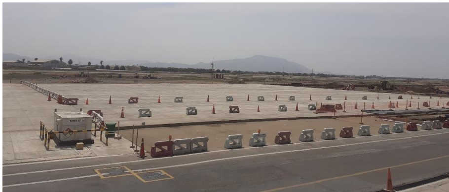
APRON culminada al 100%
