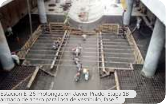
Estación E-26 Prolongación Javier Prado-Etapa 1B armado de acero para losa de vestíbulo, fase 5
