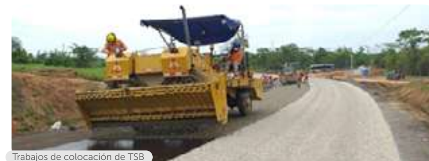
Trabajos de colocación de TSB
