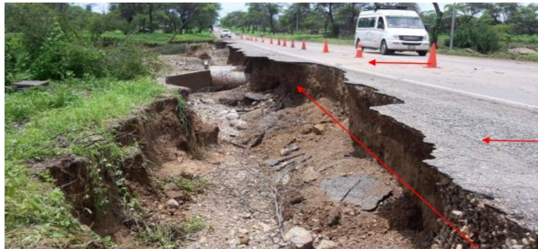
Km. 197+600 al Km 197+680– Tramo 5
