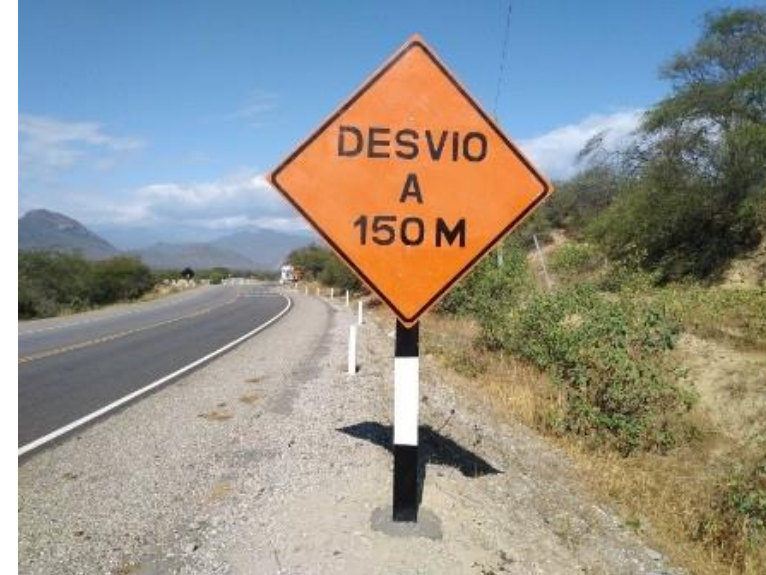
Km 139+100 – Km 139+300 - Tramo 5
