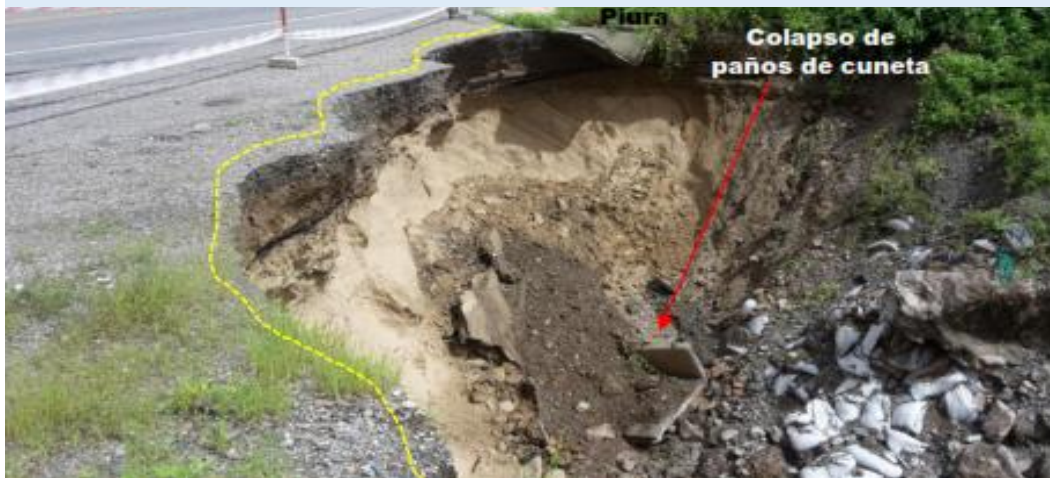
Km. 148+550- Km.148+560 – Tramo 5
