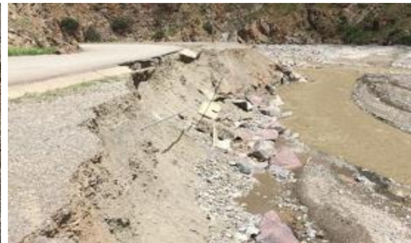
Km. 60+100 al Km 65+500 – Tramo 4
