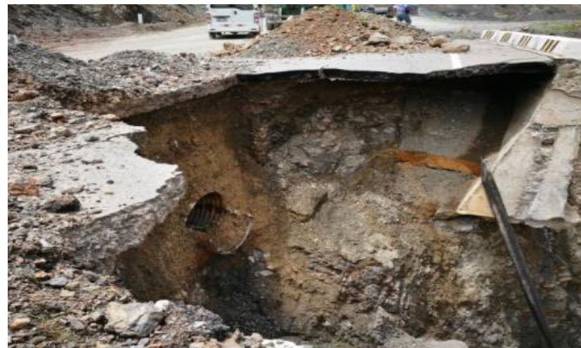
Km. 58+990 al Km 59+020 – Tramo 4
