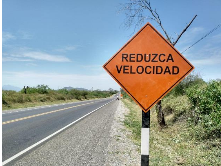
Km 194+925 – Km 194+950 – Tramo 5
