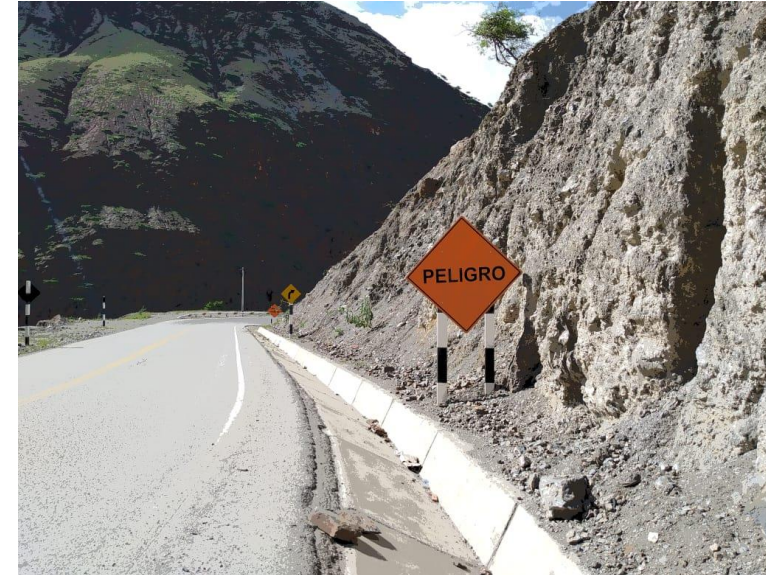
Km 58+990 - Km 59+020 – Tramo 4
