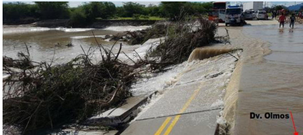
Km 131+790 al Km 132+000 - Tramo 5
