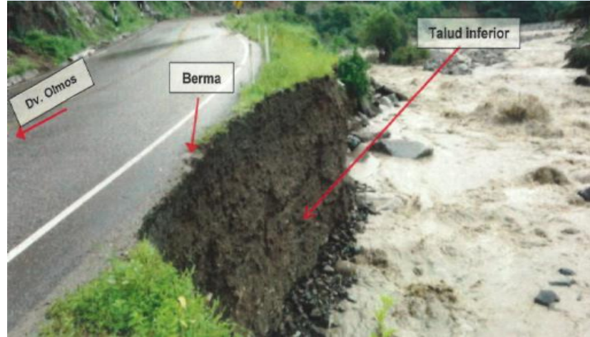
Km. 18+150 al Km 18+230 Tramo 4
