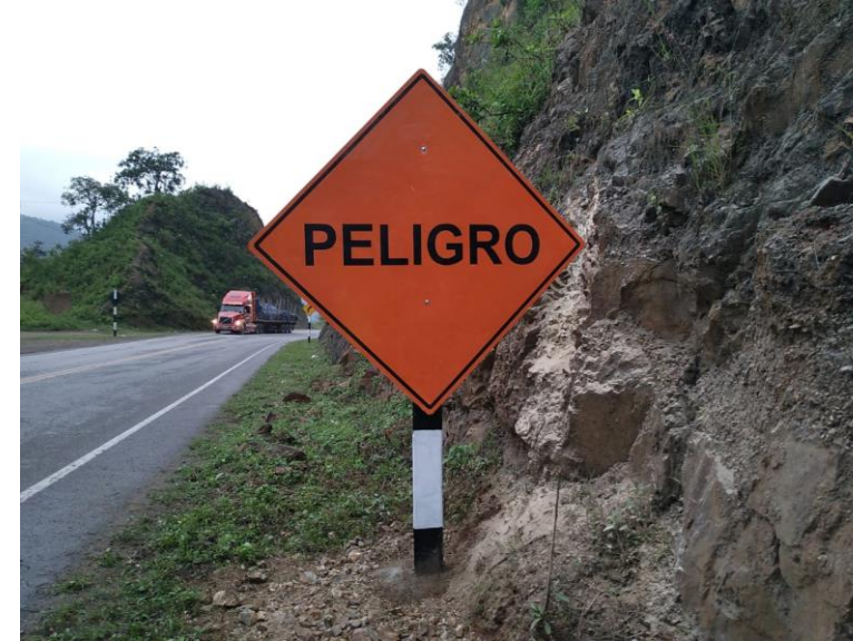
Km 24+940 - Km 25+060 - Tramo 4
