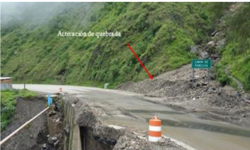
Km. 37+350 al Km 37+400 – Tramo 4
