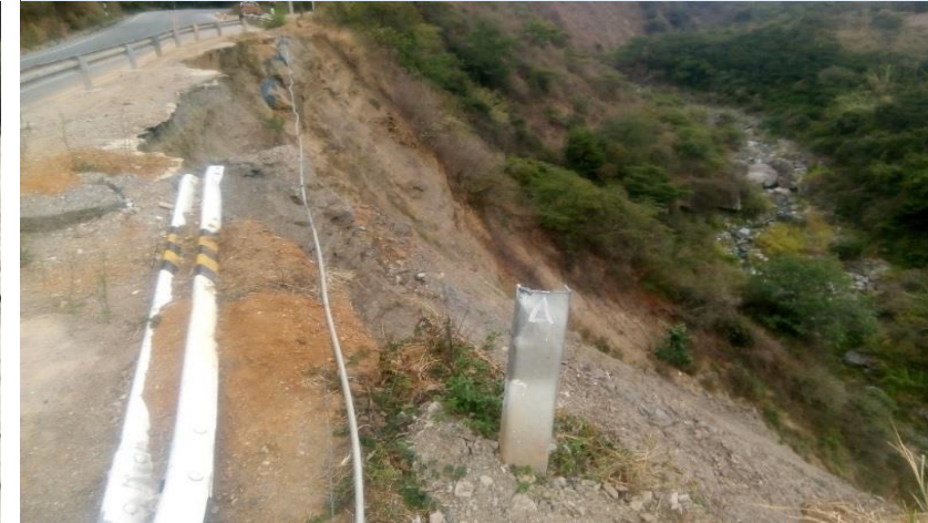
Km. 29+650 al Km 29+700 – Tramo 4
