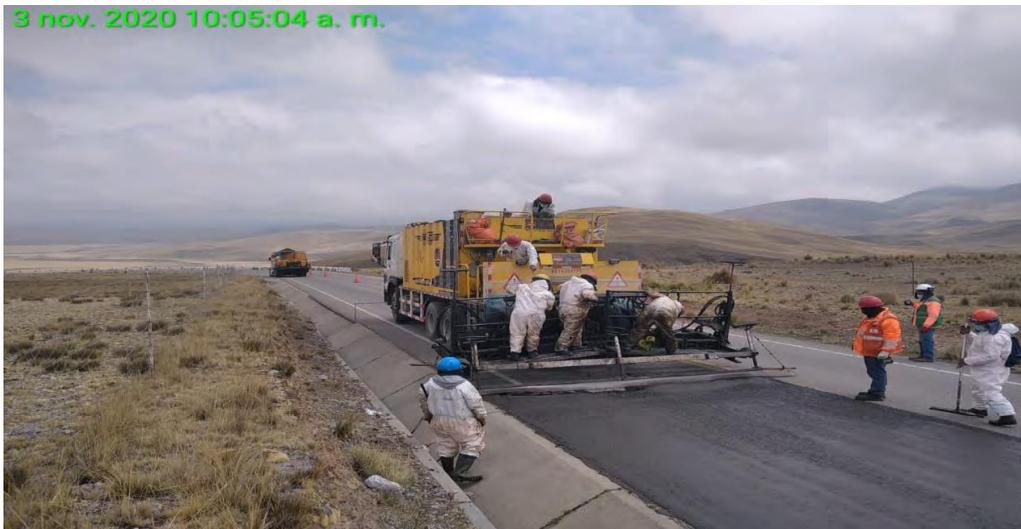
Renovación de pavimento con tratamiento superficial con micropavimento
