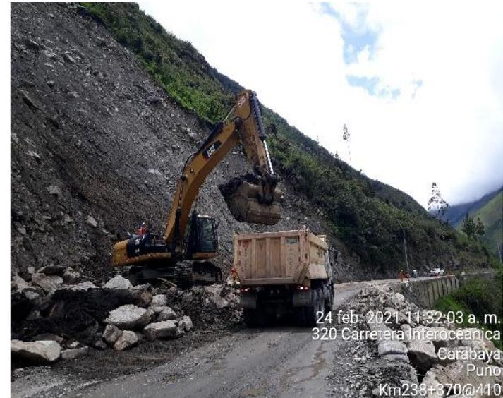
Vista de trabajos de remoción y transporte de material suelto de derrumbes
