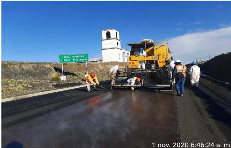
Renovación de pavimento con tratamiento superficial con micropavimento
