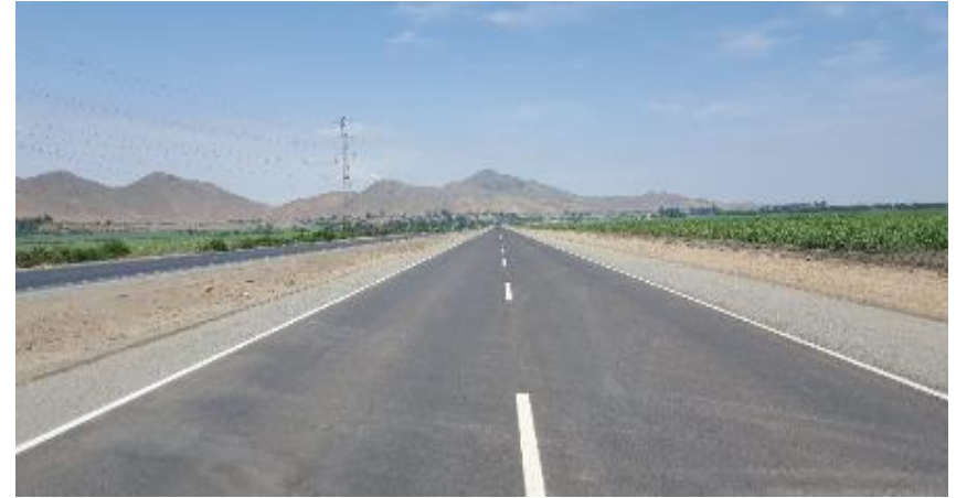
SEGUNDA CALZADA - Sector Casma – Santa (Km. 381+820 al Km. 415+170)
