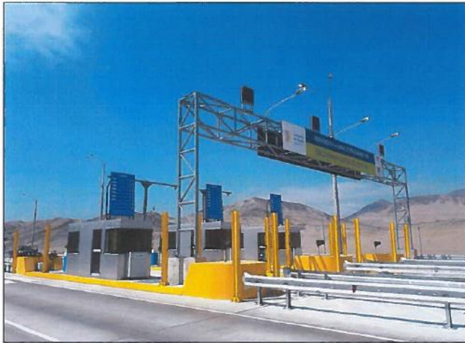
REUBICACIÓN DEL PEAJE VESIQUE CULMINADA – ESTRUCTURA DE PORTICO METALICO
