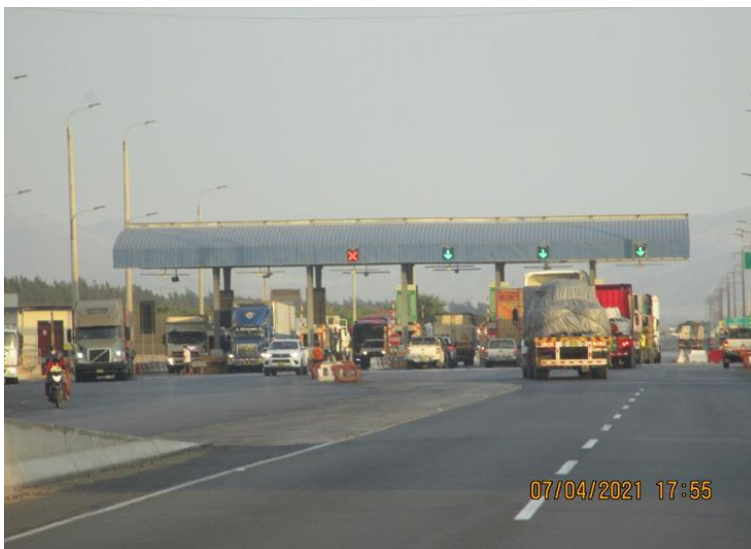
Unidad de Peaje Virú km 529+700
