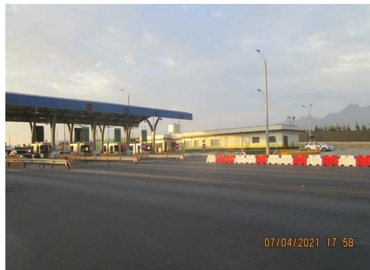
Unidad de Peaje Virú km 529+700
