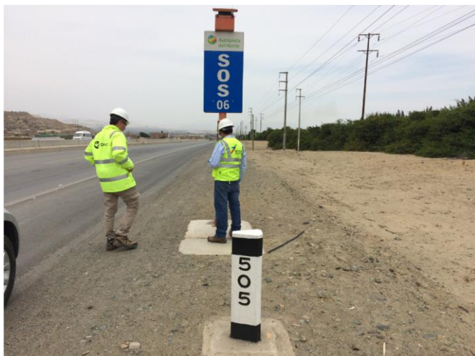
Sistema de comunicación de Emergencia (Poste S.O.S.)
