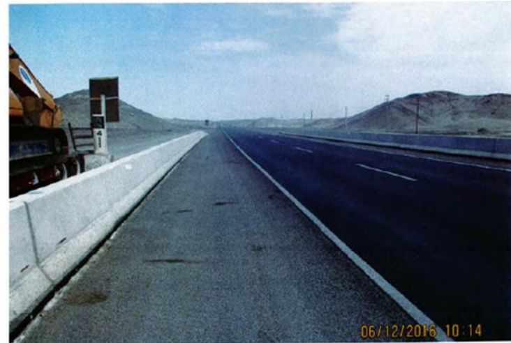
OBRA ADICIONAL MURO SEPARADOR CENTRAL – AVANCE AL 86%
