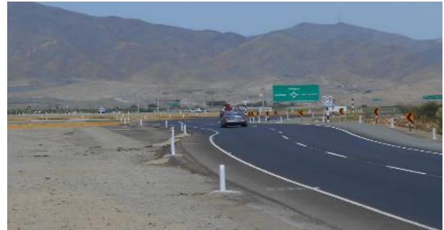
OVALO HUAMBACHO Km. 408+095 (Entre Casma y Chimbote) Estado Actual: Culminada
