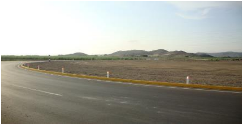
OVALO PARAMONGA Km. 206+700 al 216+020 (altura ingreso al distrito de Paramonga - Estado Actual: Culminada)
