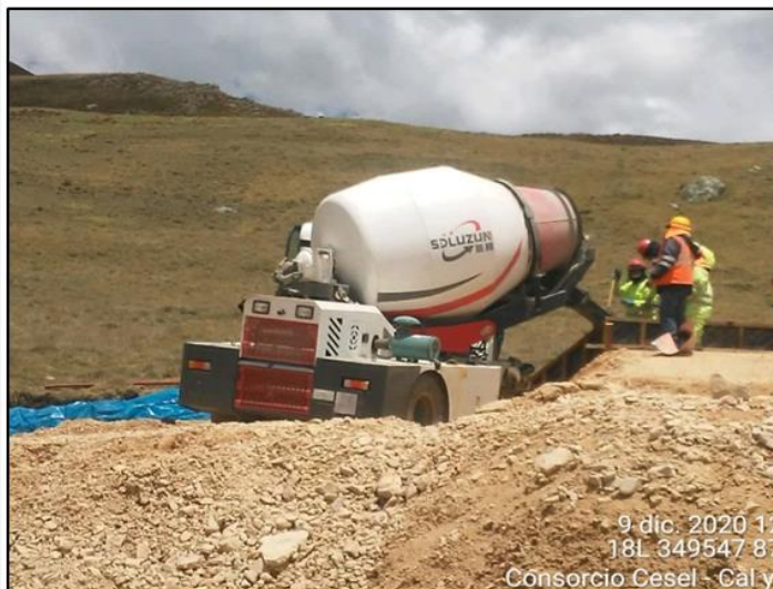
Foto N° 10. Trabajos de vaciado de concreto en cabezal de salida de alcantarilla TMC 36", km 81+600
