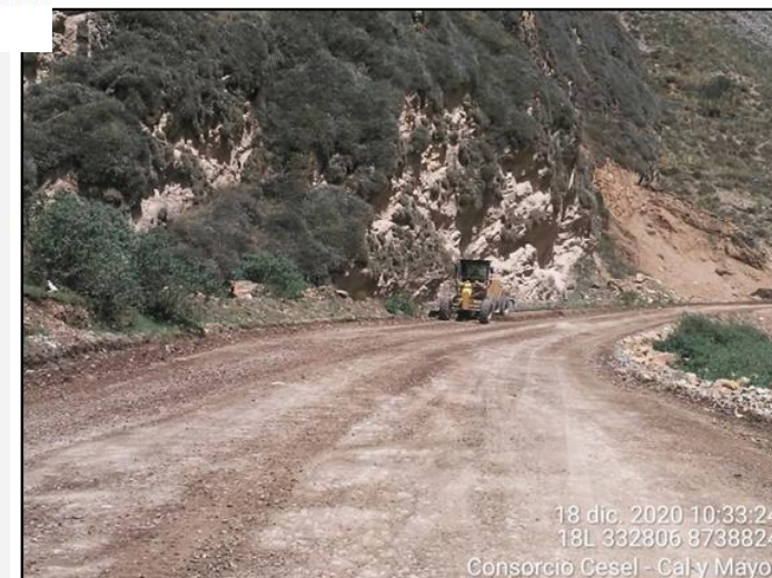
Foto N° 02. Trabajos de perfilado de plataforma existente con Motoniveladora como parte de los trabajos de Mantenimiento de Tránsito y Seguridad Vial.
