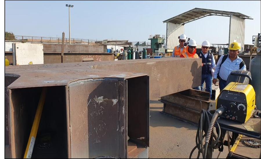
Foto 02: Verificación de fabricación de elementos vigas tirantes por parte del especialista de estructuras de la supervisión de obra.
