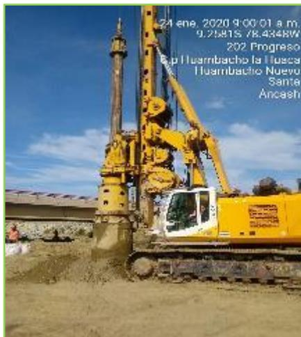
Excavación – Colocación de acero y Vaciado de concreto de pilotes – estribo izquierdo
