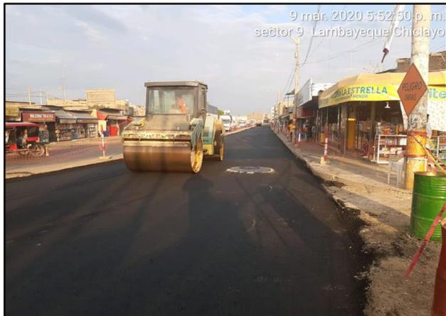
Foto N°03: Colocación de carpeta asfáltica Km. 797+050 al Km. 797+350
