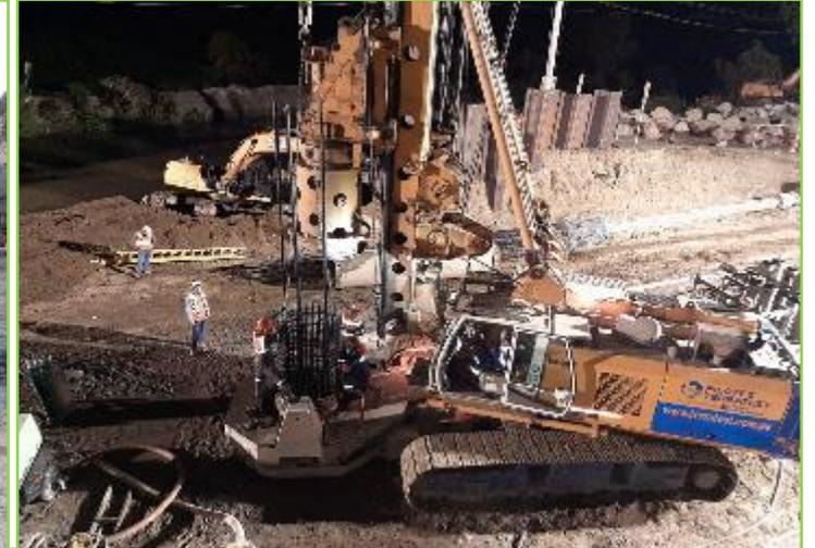
Excavación – Colocación de acero y Vaciado de concreto de pilotes – Estribo izquierdo
