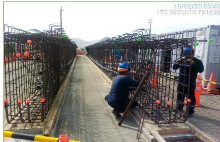
Armado de acero para vigas
