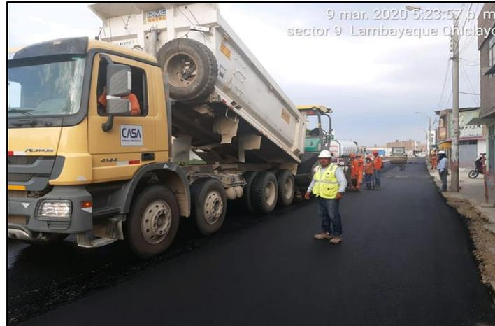
Foto N°02: Colocación de carpeta asfáltica Km. 797+050 al Km. 797+350
