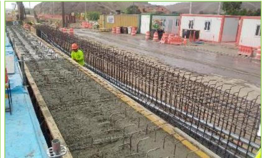
Habitación de acero y encofrado y vaciado de vigas
