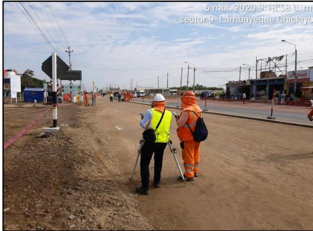
Foto N°01: Verificación de niveles base granular Km. 797+050 al Km. 797+350
