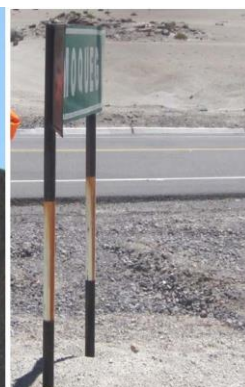
Deterioro soporte de señales
