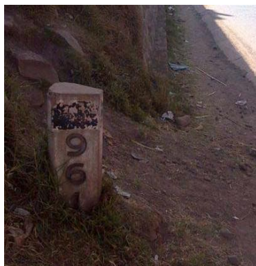
Deterioro postes kilometricos
