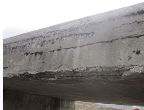
Deterioro elementos de concreto y metálicos
