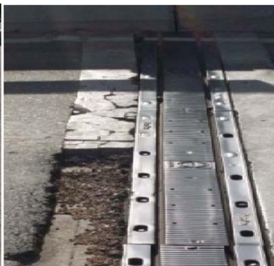
Deficiencia en las juntas
