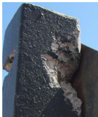
Deterioro soporte de señales
