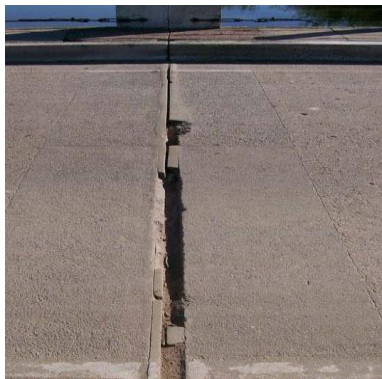
Deficiencia en las juntas
