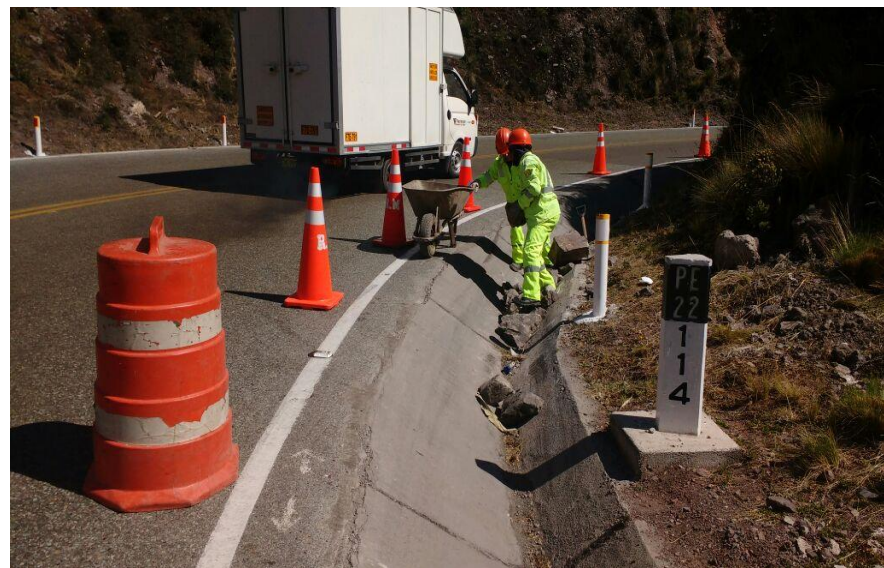
Limpieza de Cunetas
