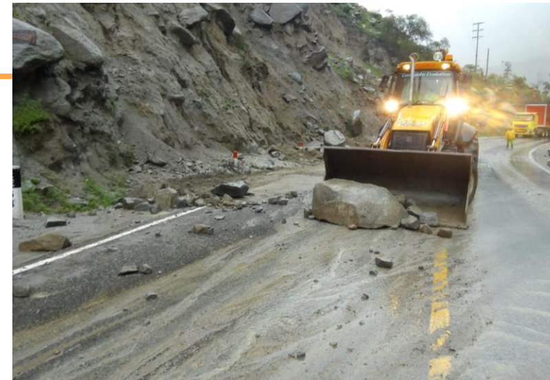
Limpieza caída de piedras
