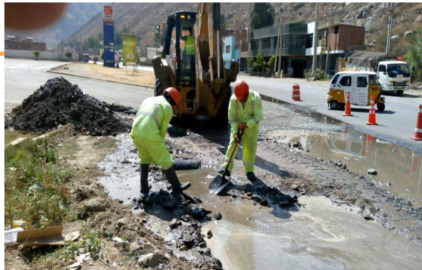
Limpieza derecho de vía
