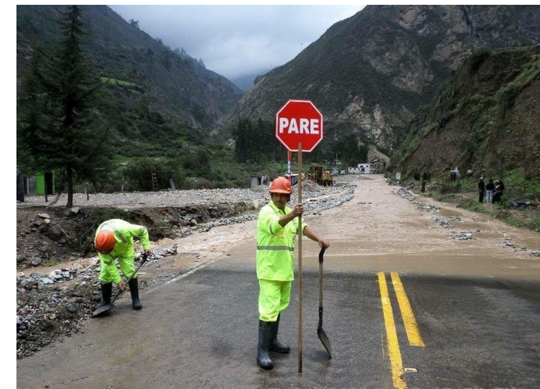
Señalización en la vía
