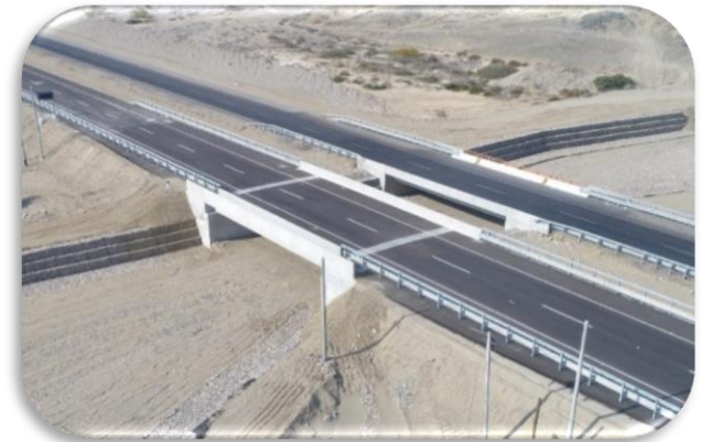
Puente San José km 659+000
