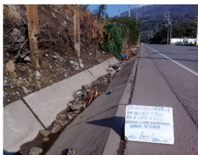
Limpieza de cuneta - Antes Sector 6: Emp.ROS3 Abancay (Pte.Sawinto) Progresiva: km 766+900 - km 767+000
