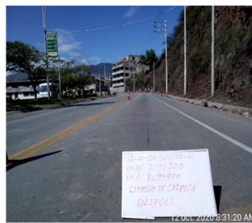
Limpieza de carpeta - Después Sector 6: Emp. R03S – Abancay Pte.Sawinto) Progresiva: km 769+300- km 769+400
