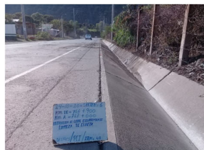
Limpieza de cuneta - Después Sector 6:Emp.ROS3 Abancay (Pte.Sawinto) Progresiva: km 766+900- km 767+000
