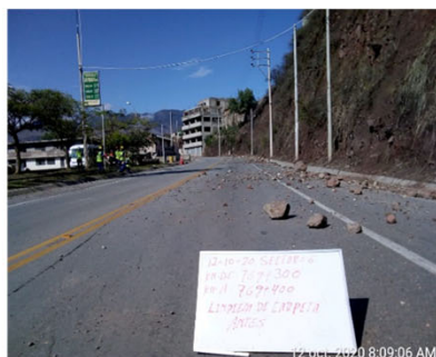
Limpieza de carpeta - Antes Sector 6: Emp. R03S – Abancay (Pte.Sawinto) Progresiva: km 769+300 - km 769+400
