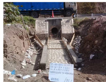
Emboquillado de alcantarilla- Antes Sector 6 Emp .R03S-Abancay(Pte.Sawinto) Progresiva: km 764+680- km 764+680
