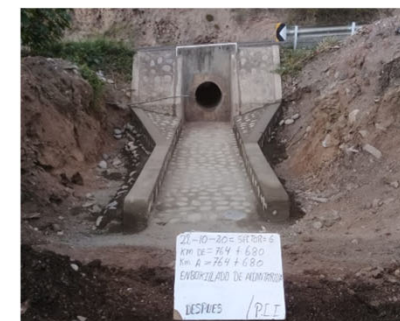
Emboquillado de alcantarilla - Después Sector 6 Emp.R03S- Abancay (Pte.Sawinto) Progresiva: km 764+680- km 764+650
