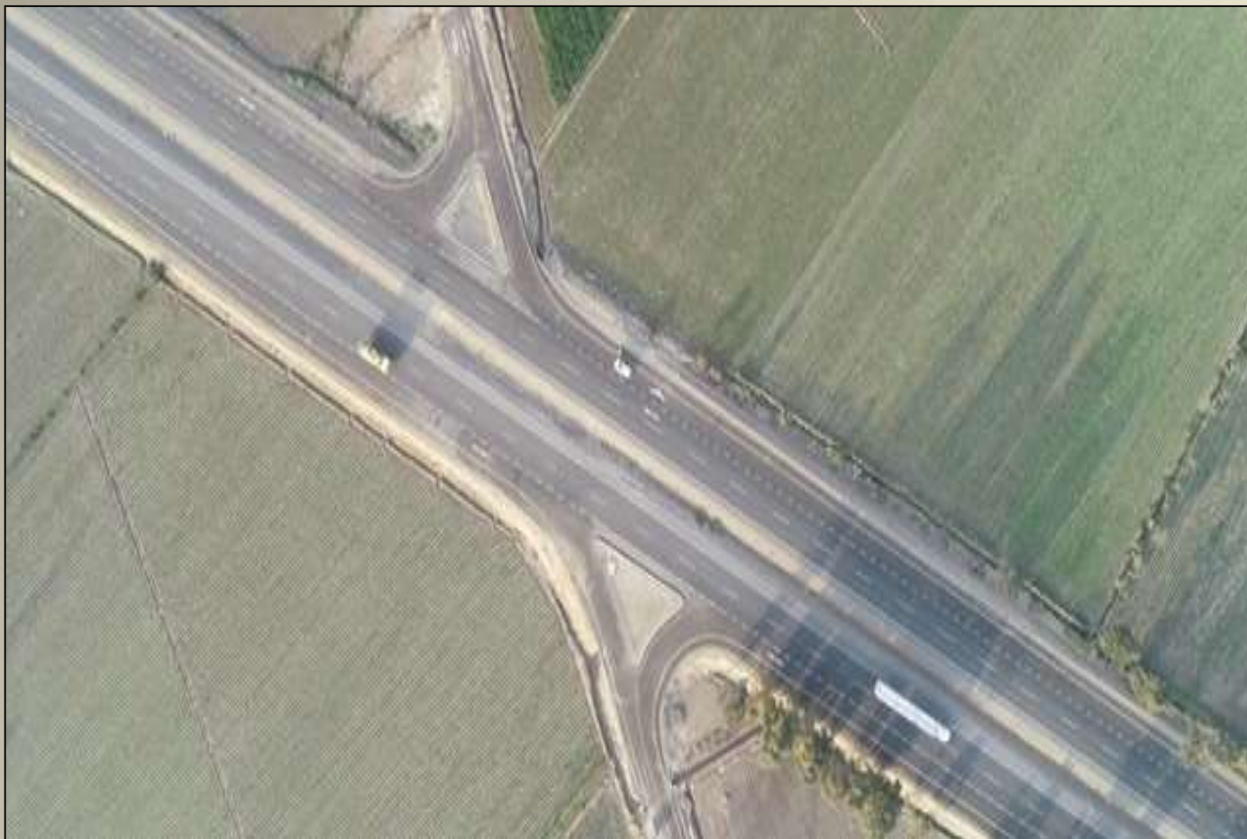
Construcción de Acceso Km 158+000
