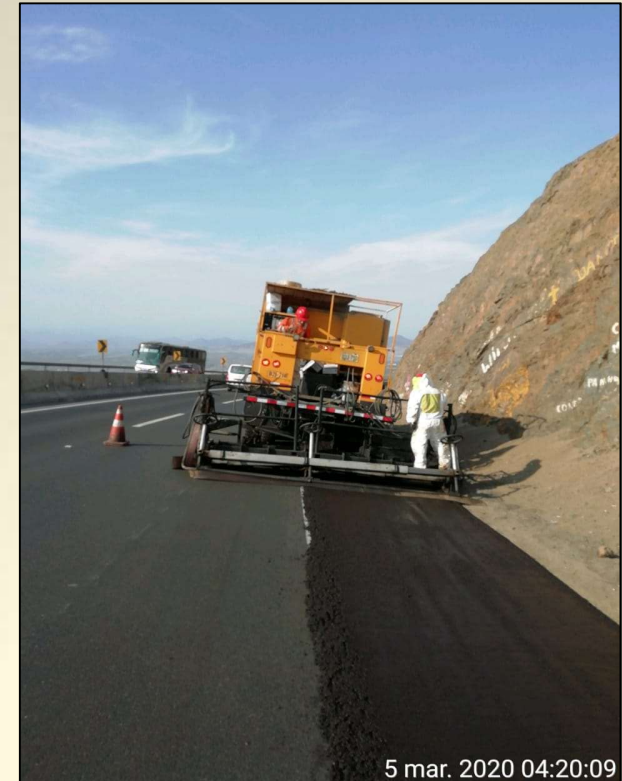
Colocación de material reciclado en bermas
