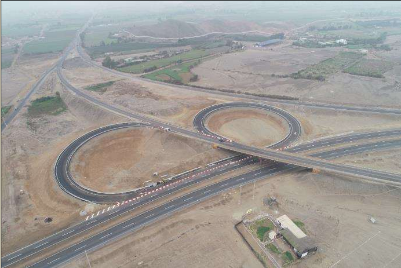
Construcción de Lazos Intercambio Vial Km 71+000
