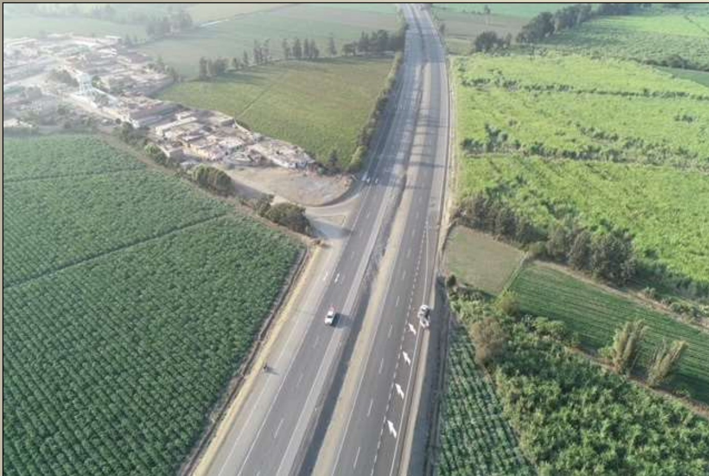
Construcción de Acceso Km 156+500
