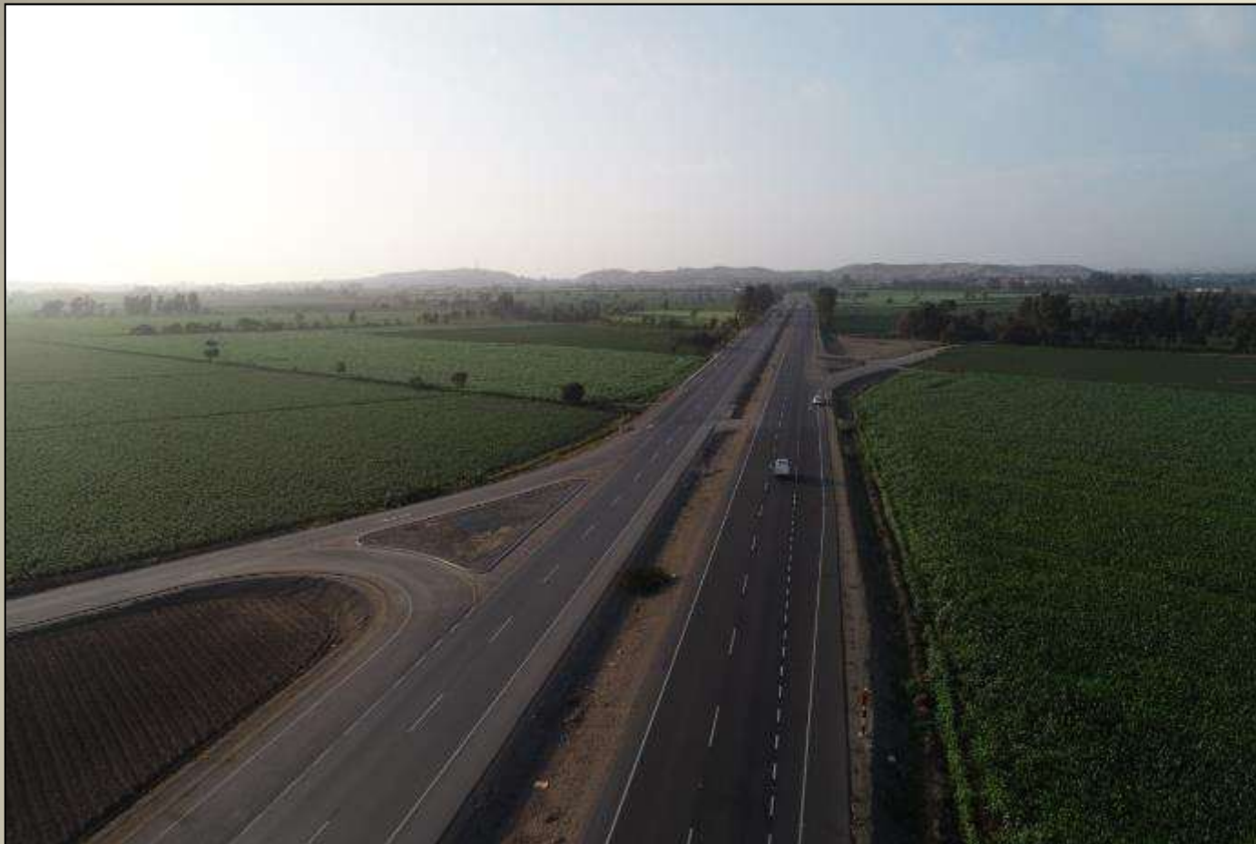
Construcción de Acceso Km 157+250
