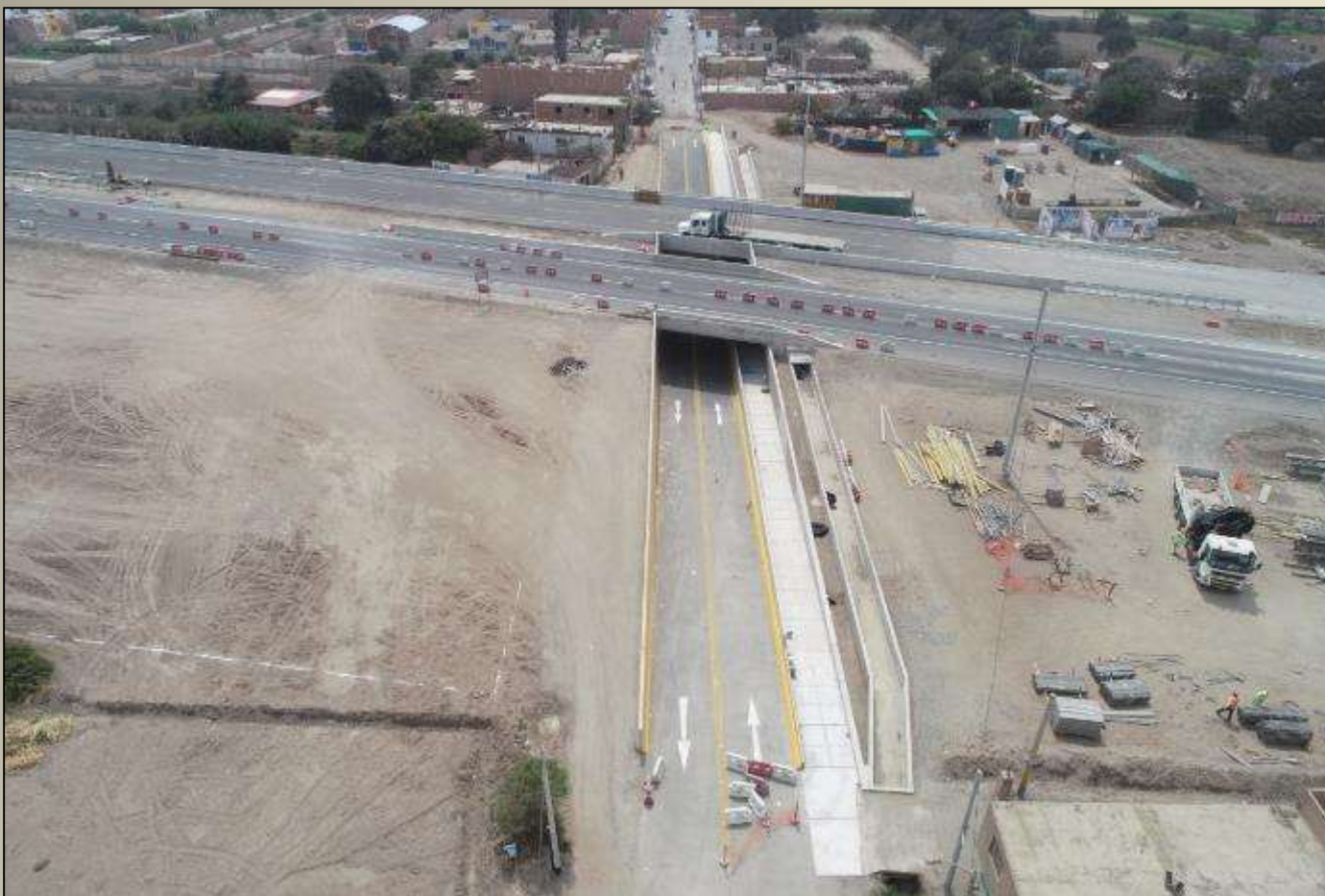
Pontón El Milagro Km 149+985
