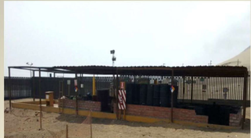
Zona de almacenamiento temporal de Residuos Peligrosos
