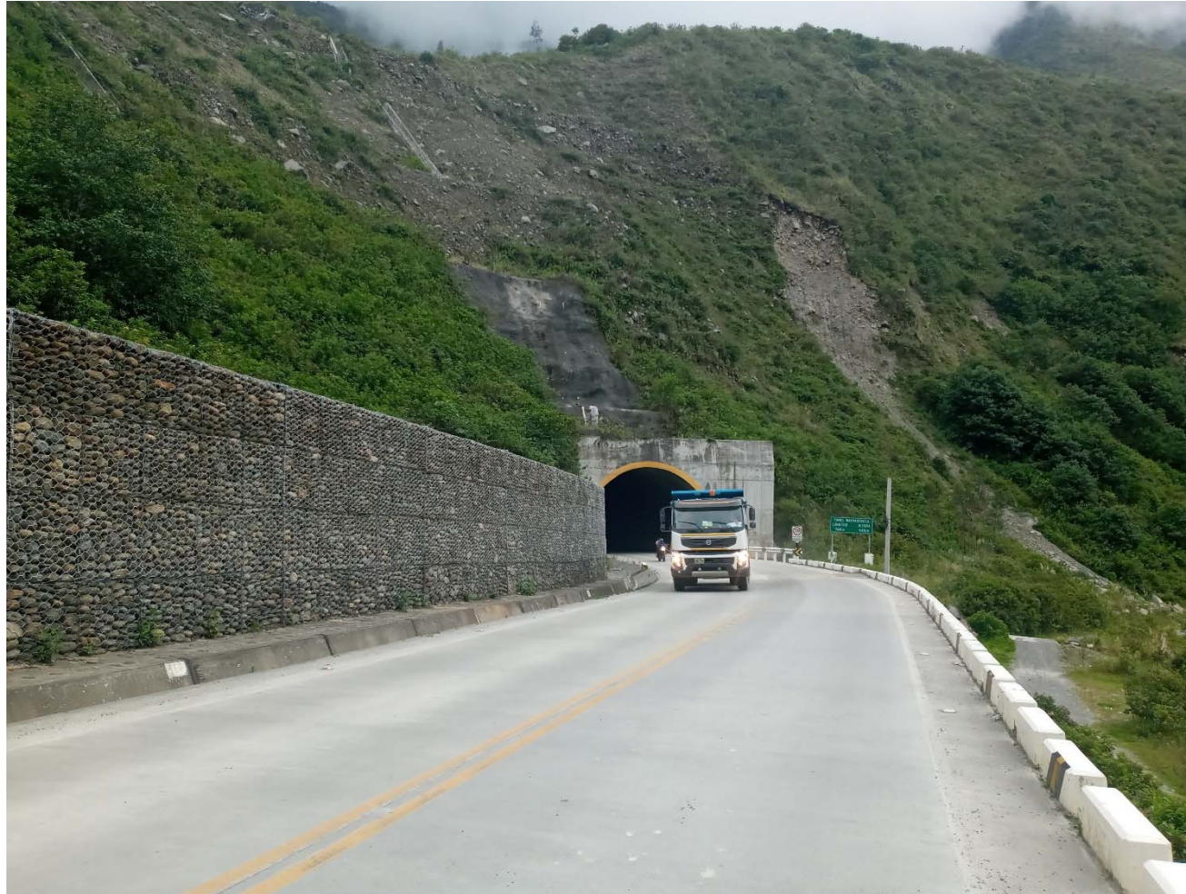
Túnel Wayrasencca Km. 237
