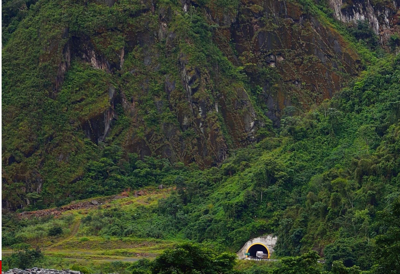
Túnel El Carmen
