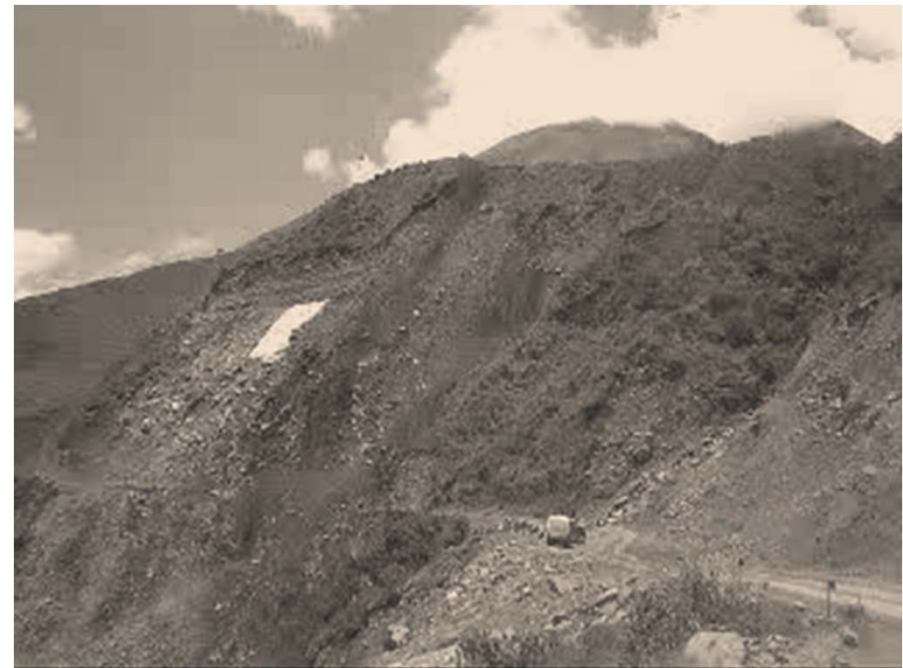
Túnel Wayrasencca (antes)
