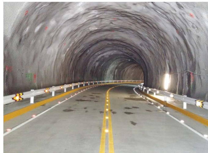
Túnel Wayrasencca (ahora)
