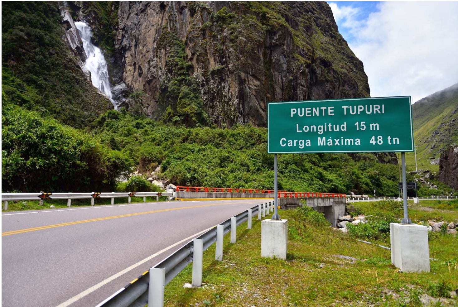
Puente Túpuri Km. 249
