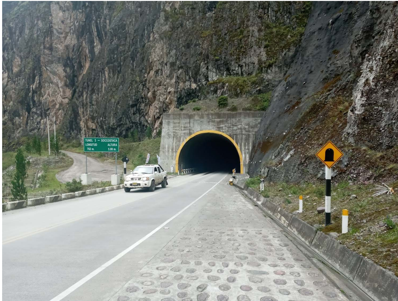
Túnel Soccostaca Km. 222
