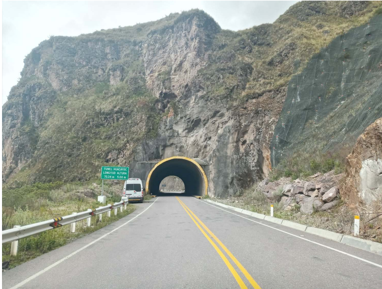
Túnel Huacayoc Km. 213
