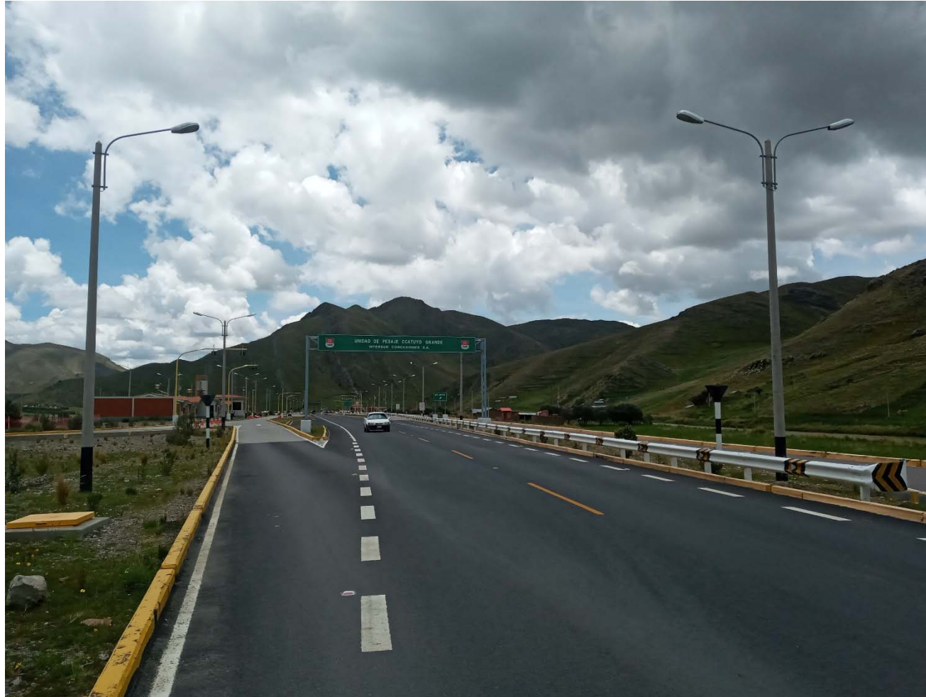
Unidad de Pesaje Ccatuyo Km. 125
