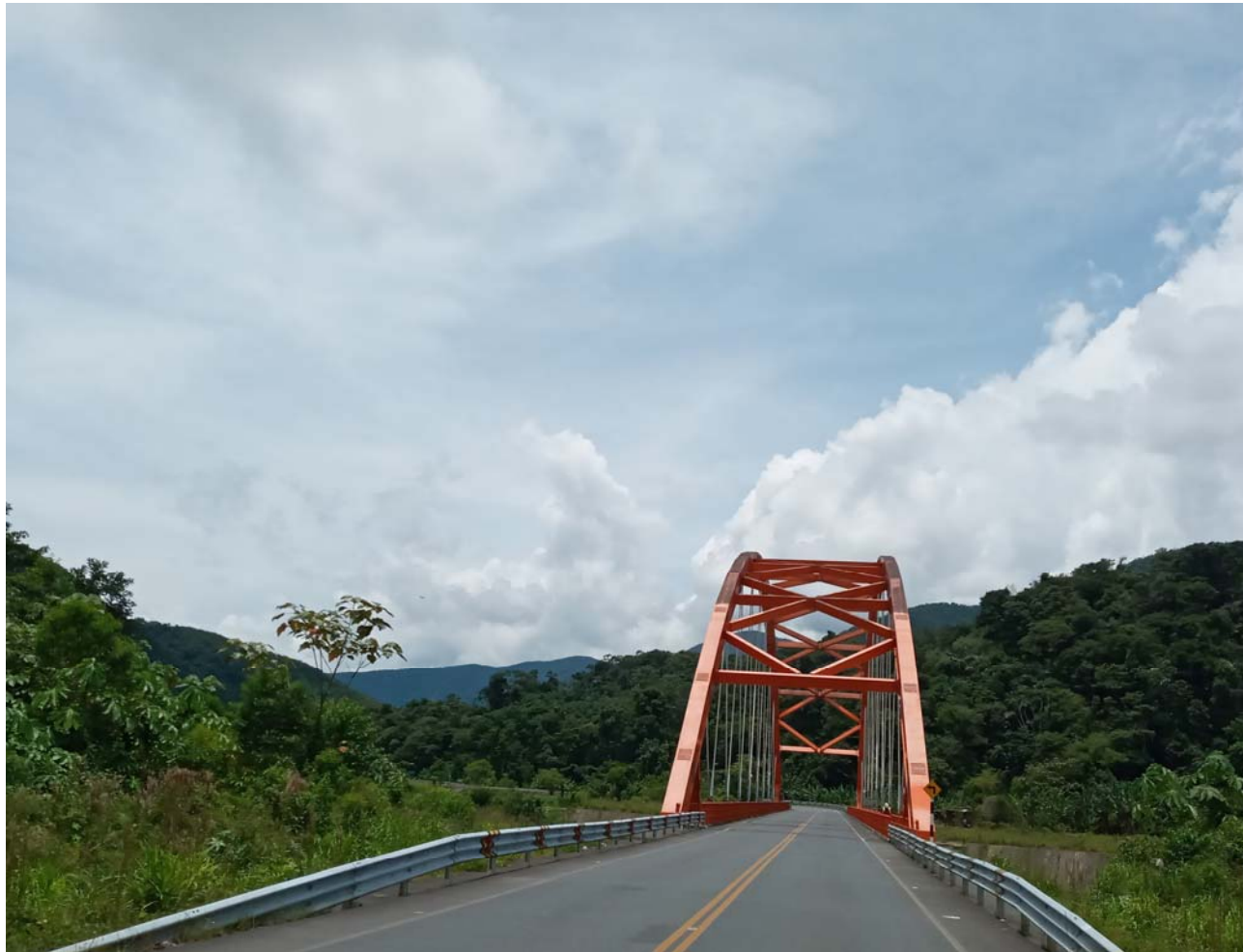
Puenle Llocllamayo Km. 295
