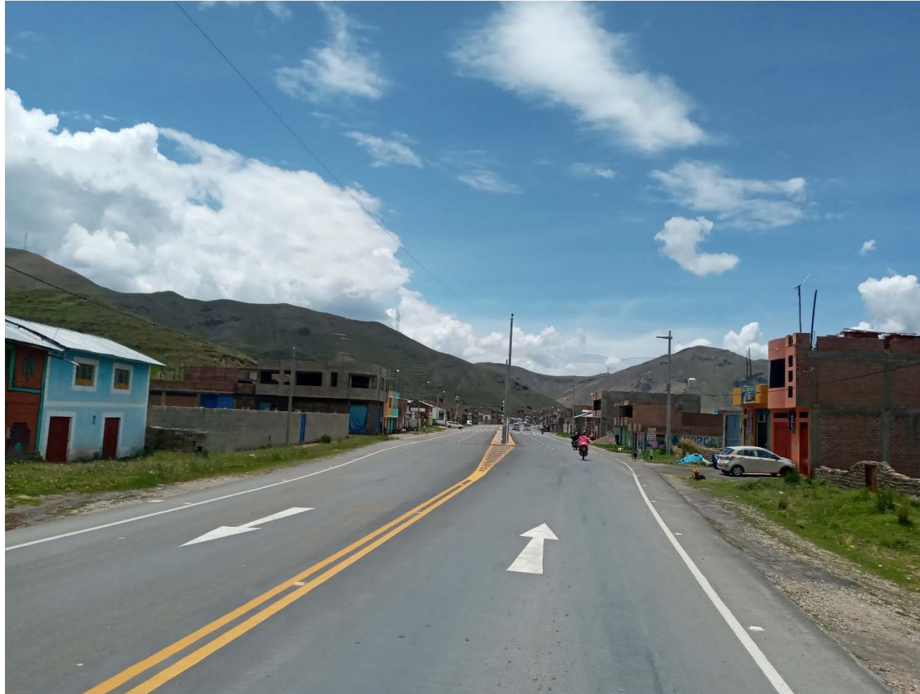
Doble vía San Antón Km. 100
