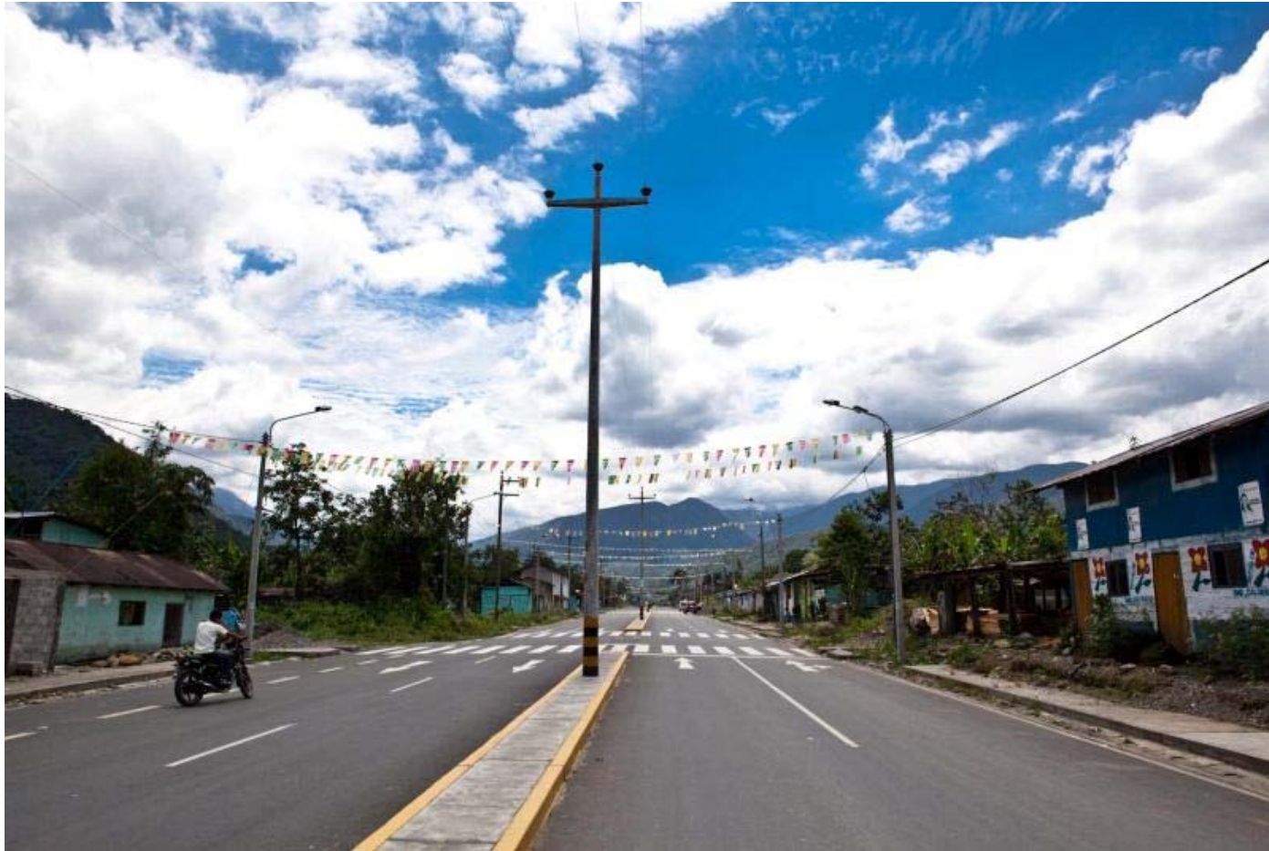
Doble Vía San Gaban Km. 292
