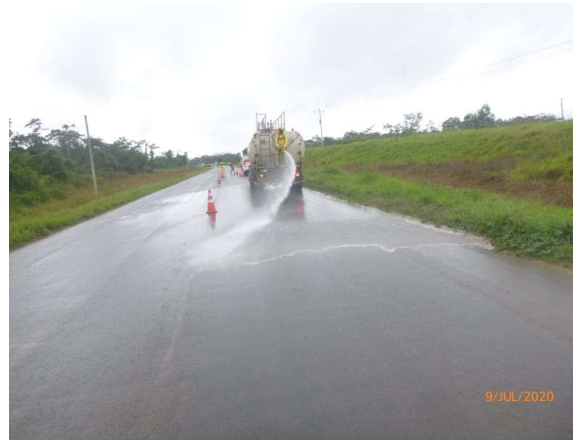
Limpieza de calzada y berma
