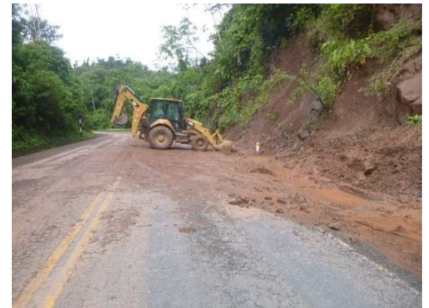
Limpieza de deslizamiento menor
