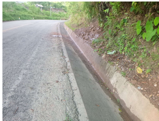
Limpieza de Cuneta
