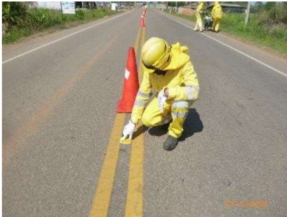
Reposición de tachas
