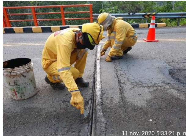
Sellado de fisuras en puentes
