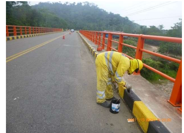
Resane de veredas en puentes/pontones
