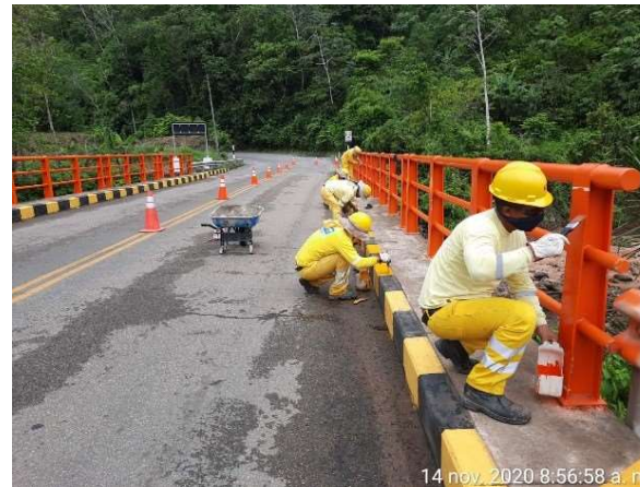
Repintado de barandas metálicas
