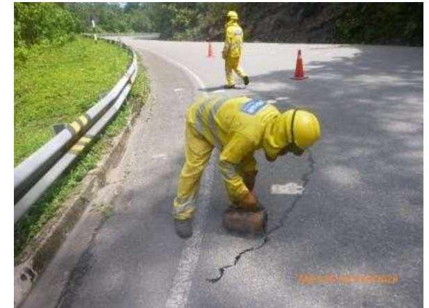
Tratamiento de fisuras
