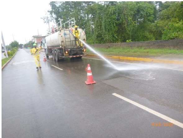
Limpieza de calzada y berma
