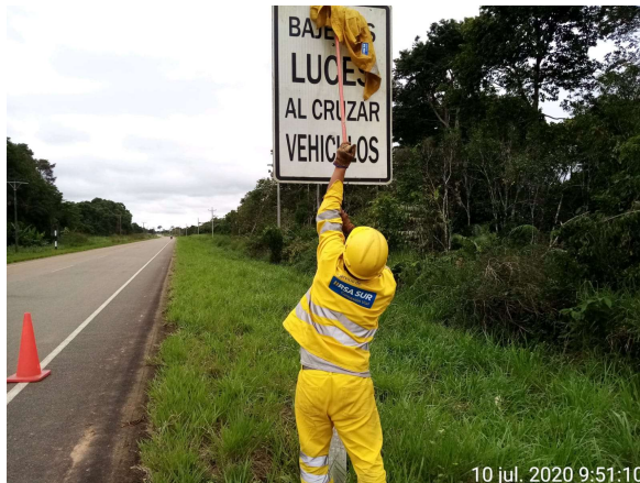
Limpieza de Placas de Señalización
