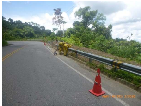
Reposición de Guardavías
