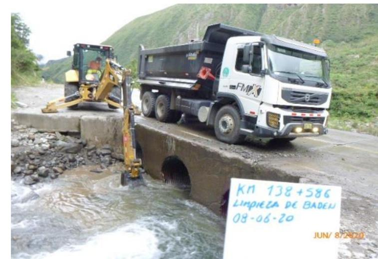
**Limpieza de superficie de concreto y dispositivos de drenaje**
