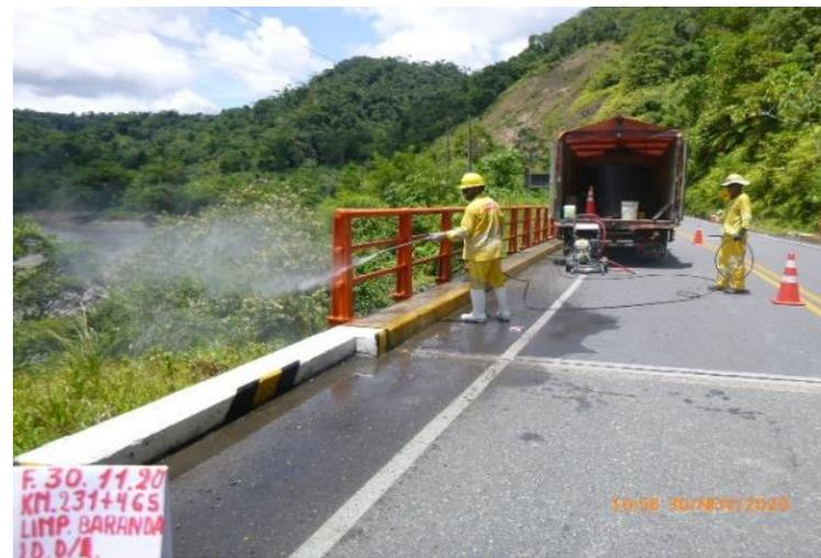
**Reparación de superficie de concreto puentes/pontones**
