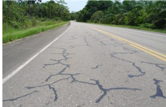
Tratamiento de fisuras
