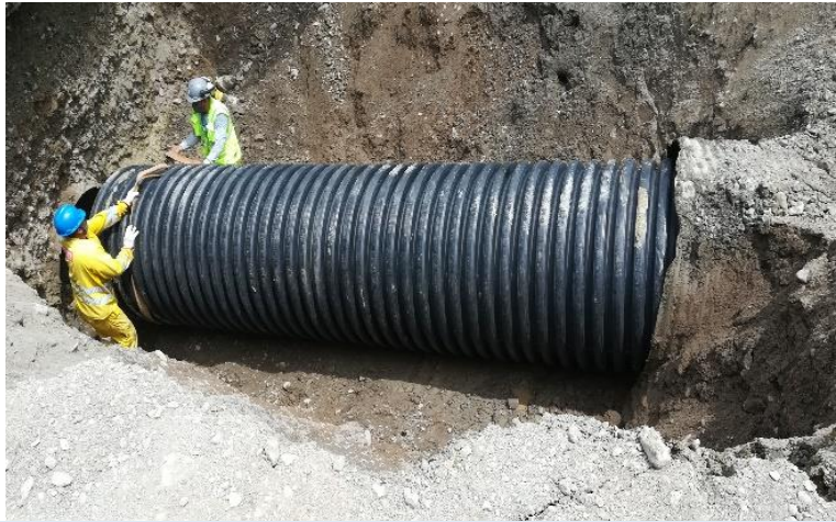
Colocación de tubo HDP de 48"
