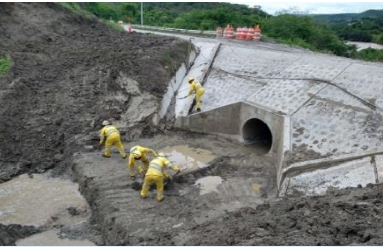
Limpeza de entrada de alcantarilla
