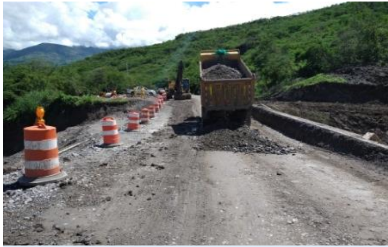
Bacheo y conformación de plataforma
