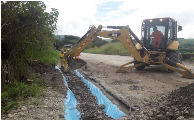
Reconformación de cuneta lateral, Excavación y prolongación de descarga de sub drenaje al pie del Muro Terramesh
