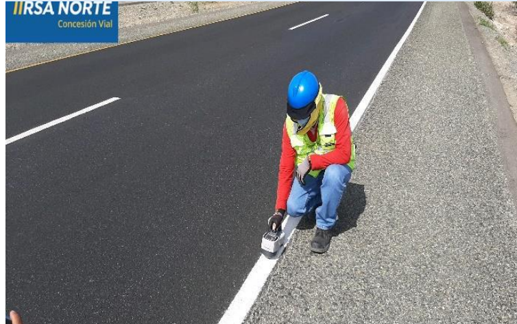
Marcas en Pavimentos y colocación de tachas reflectivas
