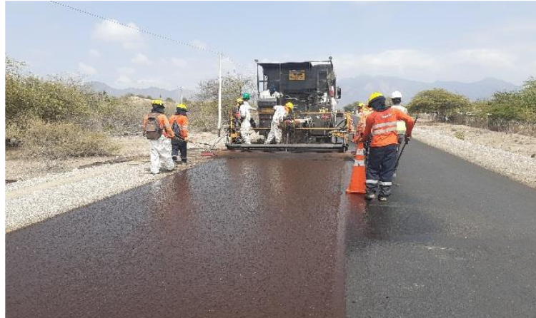
Colocación de MAC y Micropavimento e=2.5 cm
