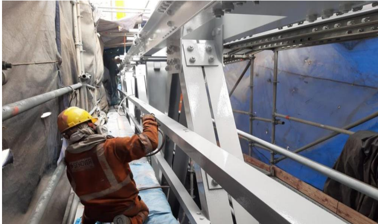
Limpieza, hidrolavado, granallado, aplicación de pintura base, intermedia, acabado y refuerzo a la estructura metálica del Puente incluye cables y péndolas
