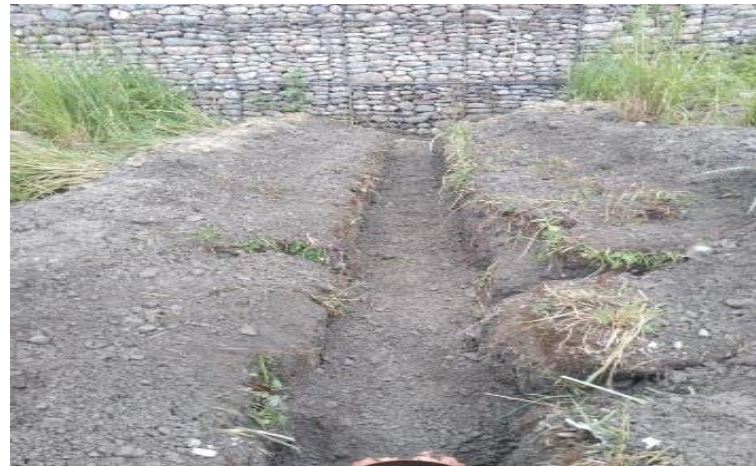
Reconformación de cuneta lateral, Excavación y prolongación de descarga de sub drenaje al pie del Muro Terramesh
