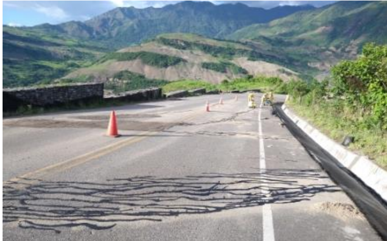
Sellado de grietas, capa nivelante con MAF
