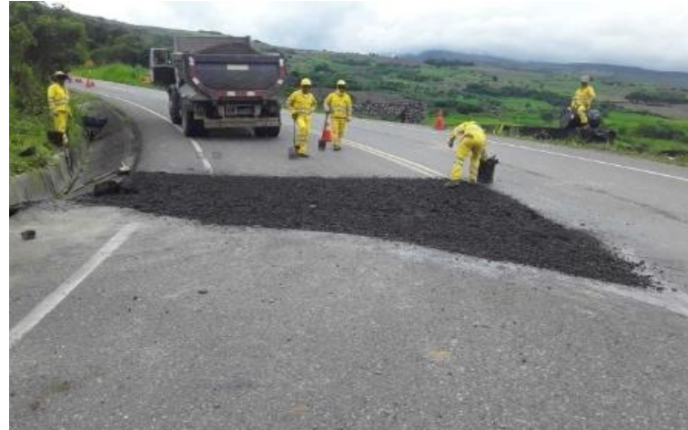
Sellado de grietas, capa nivelante con MAF
