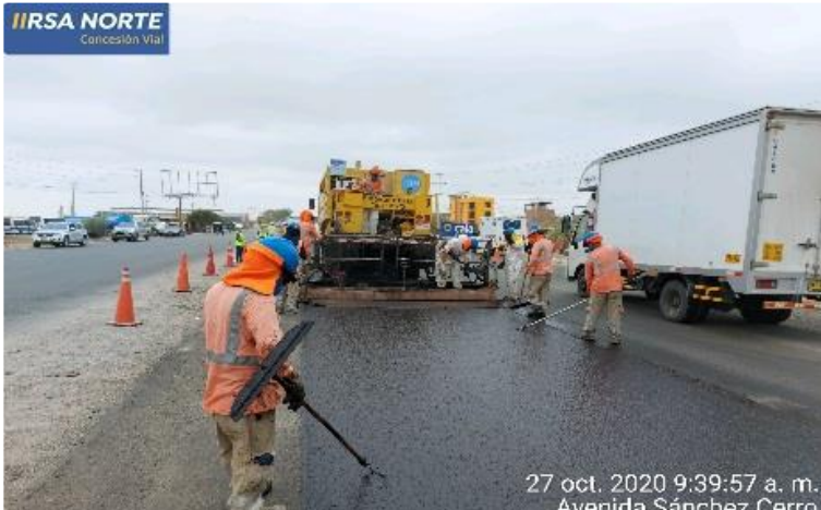
Colocación de MAC y Micropavimento e=2.5 cm
