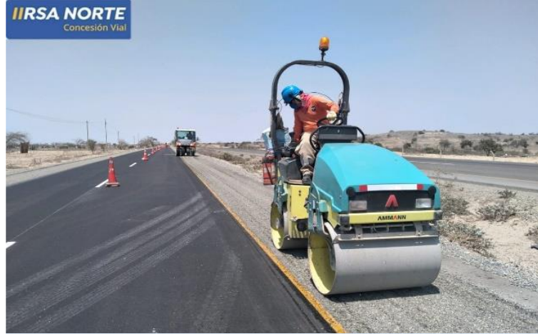
Conformación de Base granular y Tratamiento Superficial bicapa en bermas
