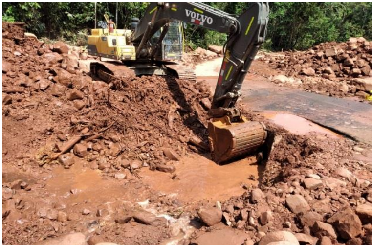
Limpieza de entrada y salida de Alcantarilla
