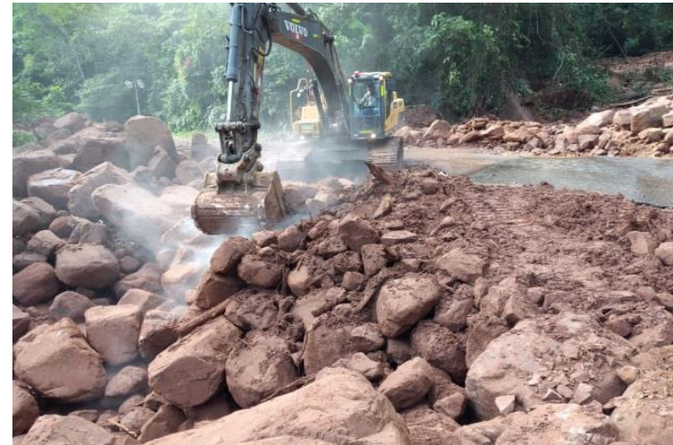
Trabajos de protección (Enrocados)
