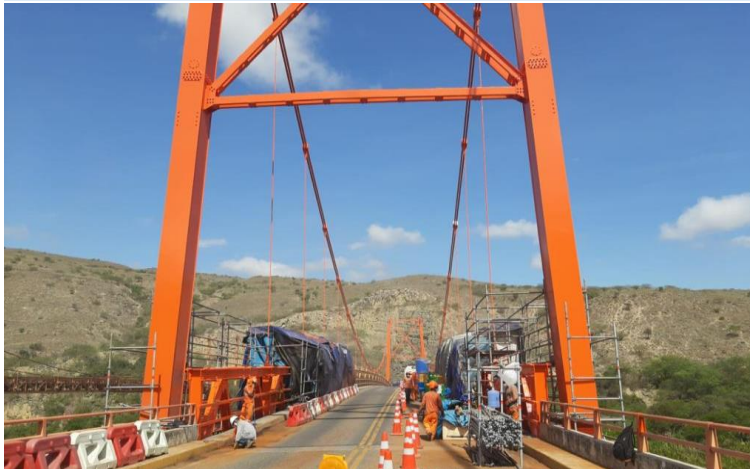
Tratamiento de juntas de dilatación, colocación de sello elastómero y sustitución de juntas metálicas. Colocación de abrazaderas en cables
