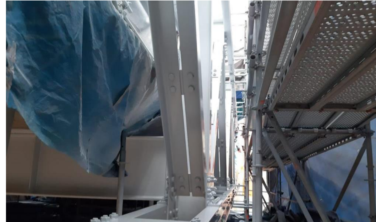
Limpieza, hidrolavado, granallado, aplicación de pintura base, intermedia, acabado y refuerzo a la estructura metálica del Puente incluye cables y péndolas
