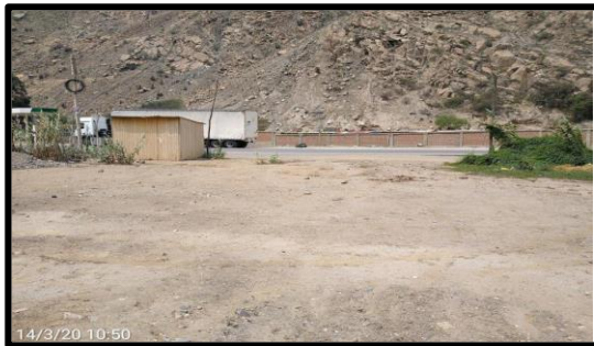
DME – Km. 047+100 SUB TRAMO 1
